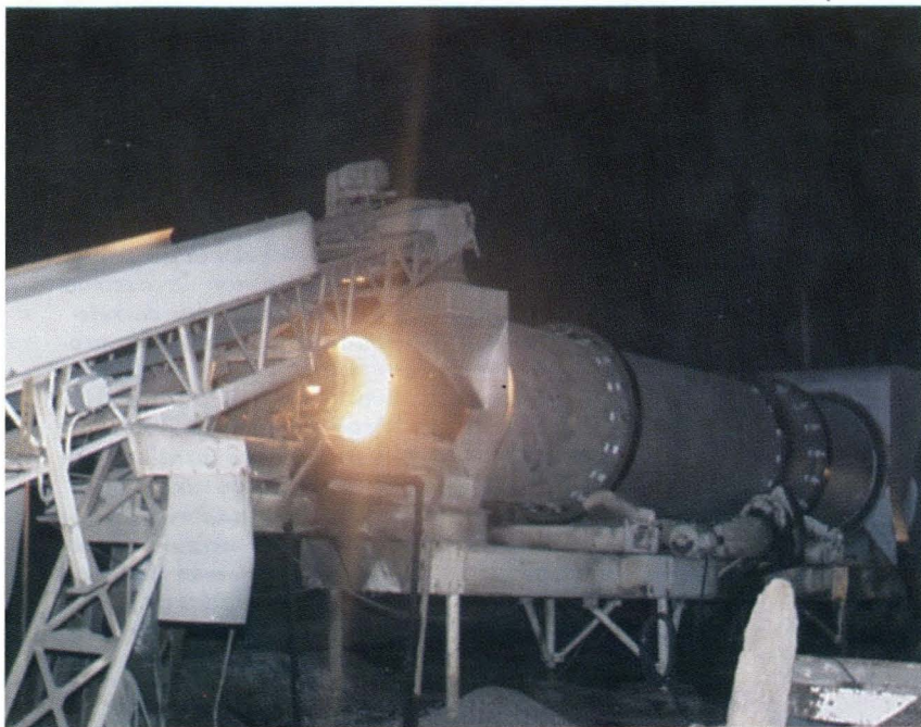
Planta procesadora de asfalto Colima.
