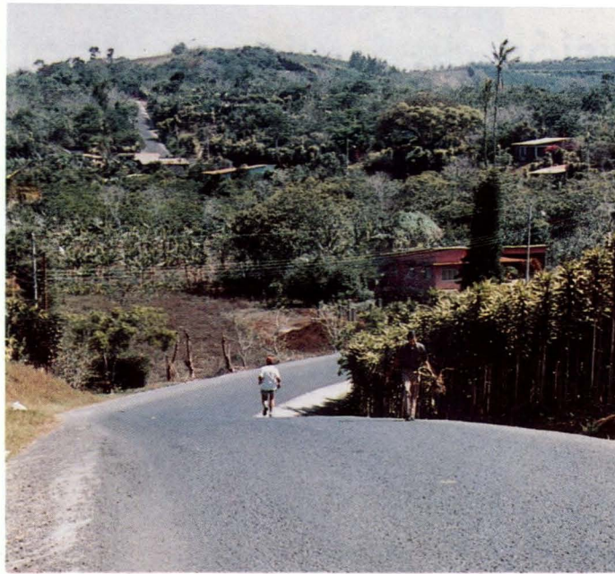
Carretera San Ramón-Peñas Blancas.
