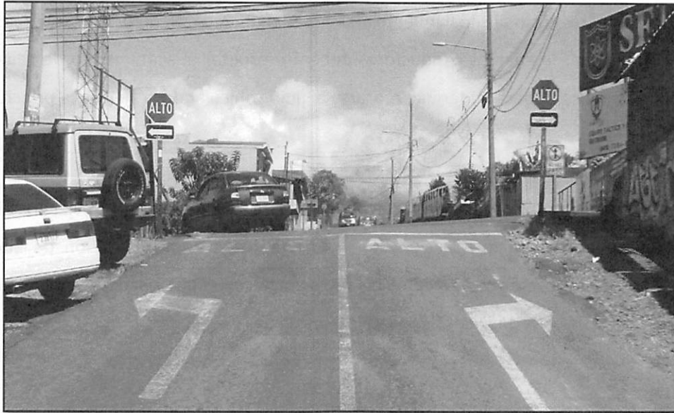
Figura 6 Acceso Sur, Calle 10, dos carriles por sentido, señalamiento vial con doble Alto, para giro derecho e izquierdo, en una pendiente ascendente superior al 5% vista Sur-Norte.
