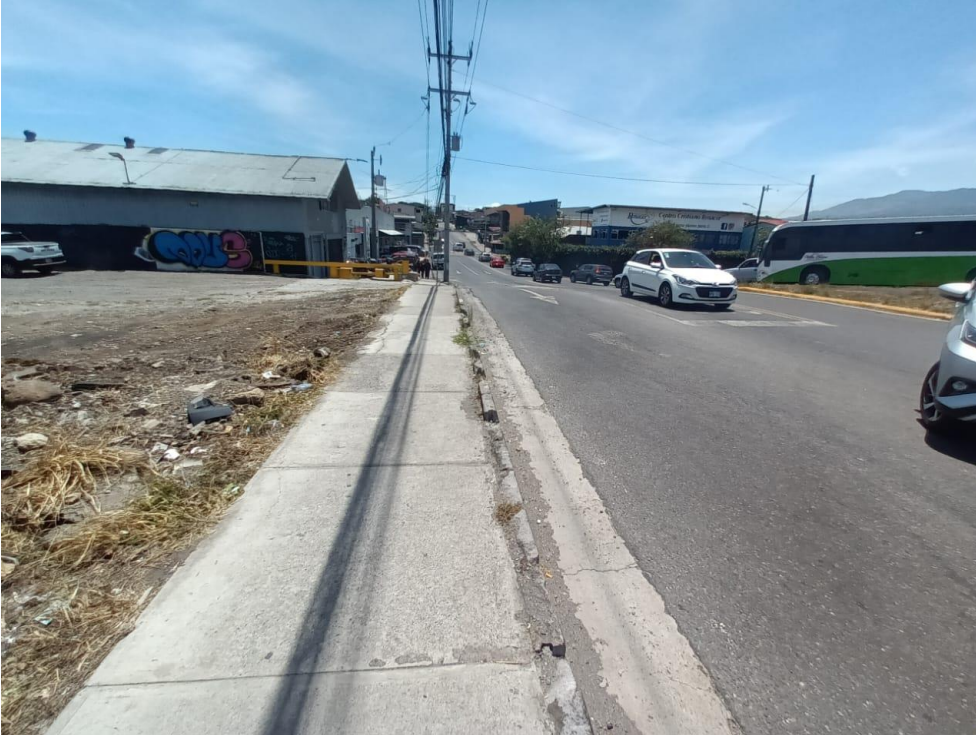
Figura 4 Acceso norte de intersección RN N.º 210 – RN N.º 252, Curridabat, San José. Fuente: (Piedra, 2023).
