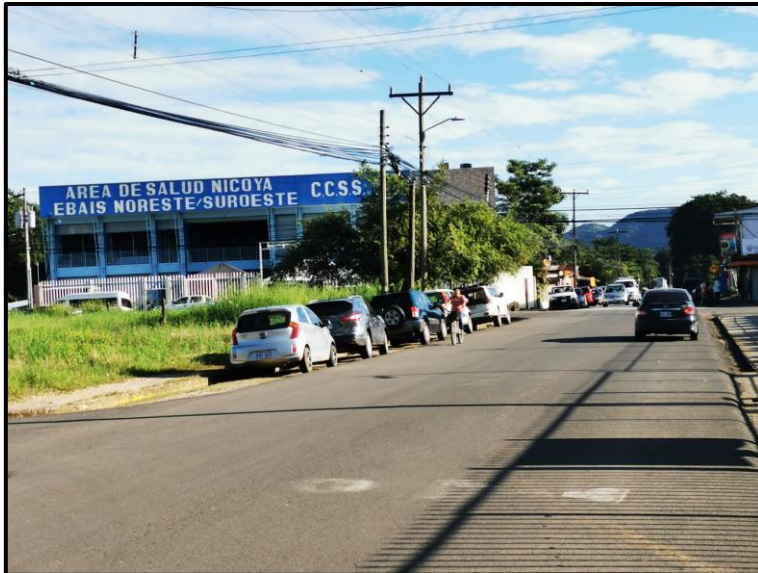
Imagen N° 2. Carpeta Asfáltica Ruta Nacional N° 21.
