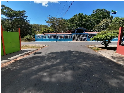
Figura N° 3 Vía cantonal, en el sector de la escuela
