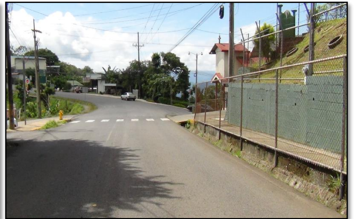
Figuras 4 Escuela de Junquillo Arriba, Santiago de Puriscal, Ruta Nacional N°239, vista de acera y malla de protección y paso de cebra en la calzada, sentido Oeste-Este.
