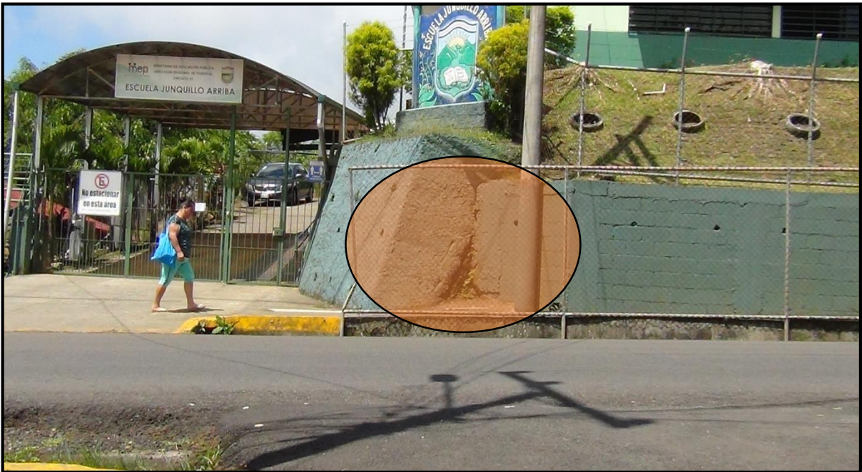
Figuras 7 Escuela Junquillo Arriba, Ruta Nacional 239, paño de malla ciclón a ser eliminada para instalar paso pe y semáforo peatonal.
