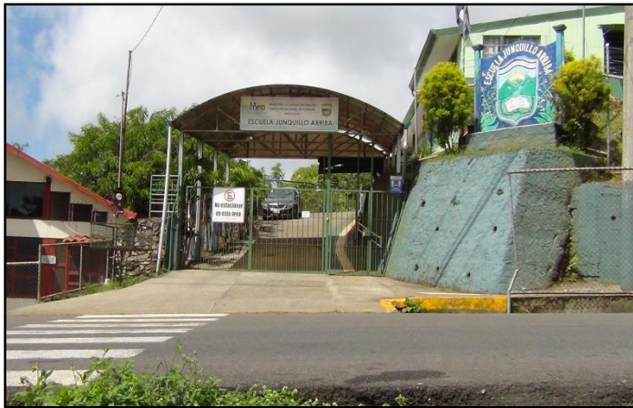
Figuras 3 Escuela de Junquillo Arriba, Santiago de Puriscal, Ruta Nacional N°239, vista del acceso peatonal y vehicular del centro educativo.
