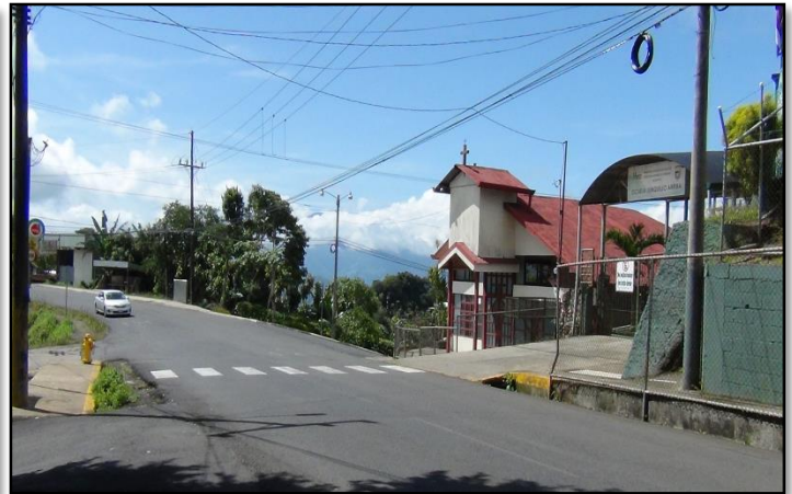
Figuras 6 Escuela de Junquillo Arriba, Santiago de Puriscal, Ruta Nacional N°239, vista de acera y malla de protección y paso de cebra en la calzada, sentido Oeste-Este.
