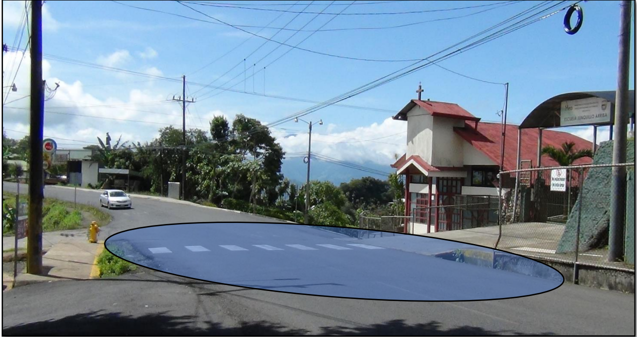
Figuras 7 Escuela Junquillo Arriba, Ruta Nacional 239, Zona propuesta para la instalación del paso peatonal frente a los muros del centro educativo.
