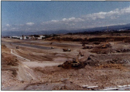
La Dirección General de Aviación Civil del MOPT emprendió, las obras de ampliación de la pista del Tobías Bolaños.
