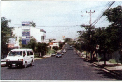
El programa de recarpeteo de vías que se inició con los cuadrantes de la ciudad de San José se extendió después a las provincias, entre ellas la de Alajuela.
