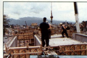
La losa de concreto de la vía Cruce Moravia - Cruce Ipís, tiene un espesor de 23 cm, lo que garantiza una mayor vida útil.
