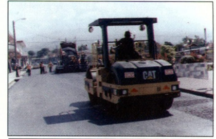
Unos ¢ 80.000 millones invirtió CONAVI en el mantenimiento de los 4.200 kilómetros de la red vial asfaltada, con obras de recarpeteo como las realizadas en la provincia de Cartago.
