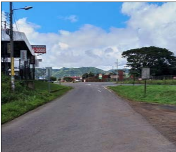
Figura N° 4 Cuneta, zona verde y señalización vial, ausencia de aceras
