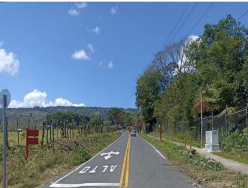
Figura 4. Señalización vial realizada acceso oeste
