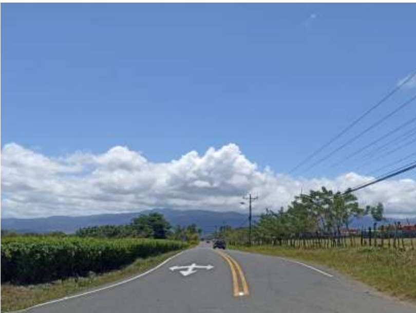
Figura 6. Señalización vial realizada acceso sur
