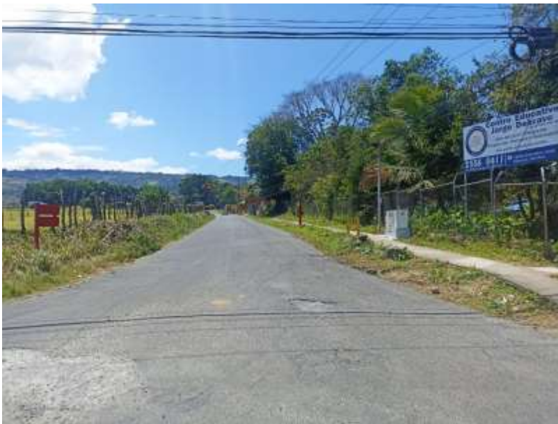
Figura 2. Superficie de rodamiento acceso oeste de la interacción
