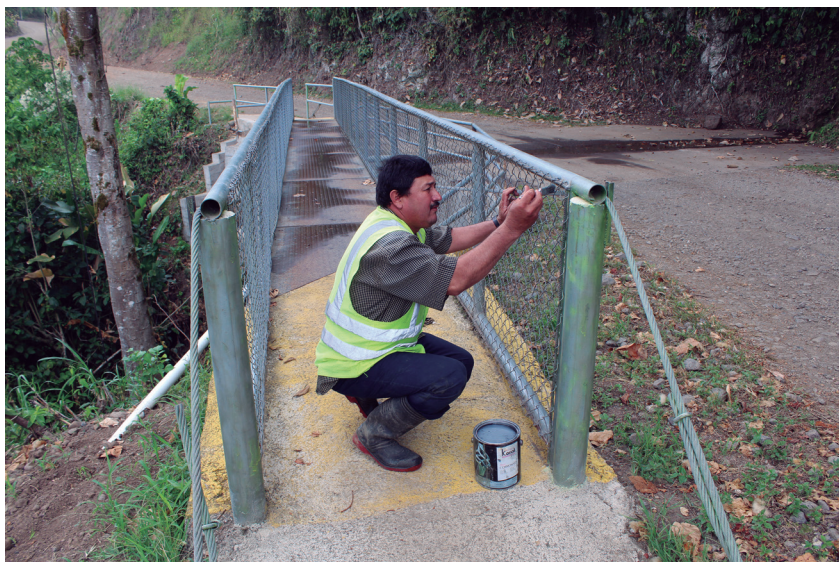
Labores de limpieza de puentes. COOPEPUEBLOS UNIDOS R.L. En Silencio, Sitio Mata cantón de Turrialba
