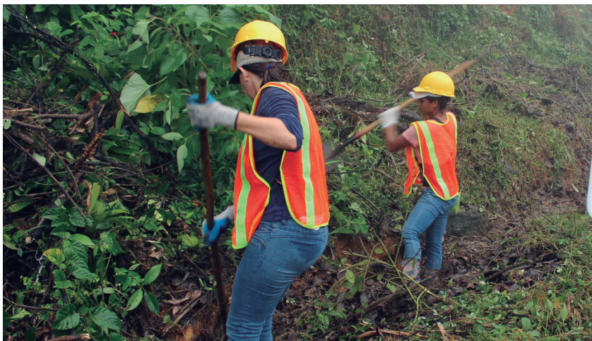
Limpieza de cunetas en Río Celeste, cantón Guatuso
