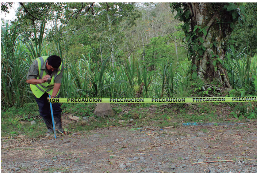
Labores de atención de emergencia en caminos cantonales
