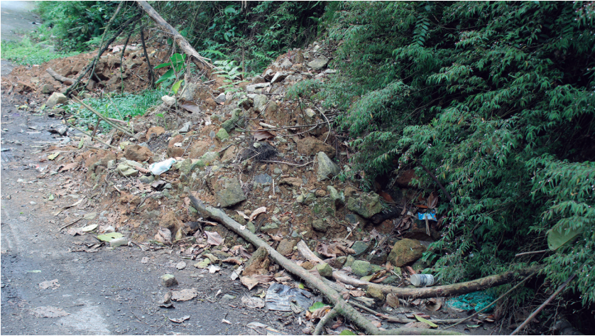
Mantenimiento Vial en Proyecto PRVC-I, cantón Tarrazú
