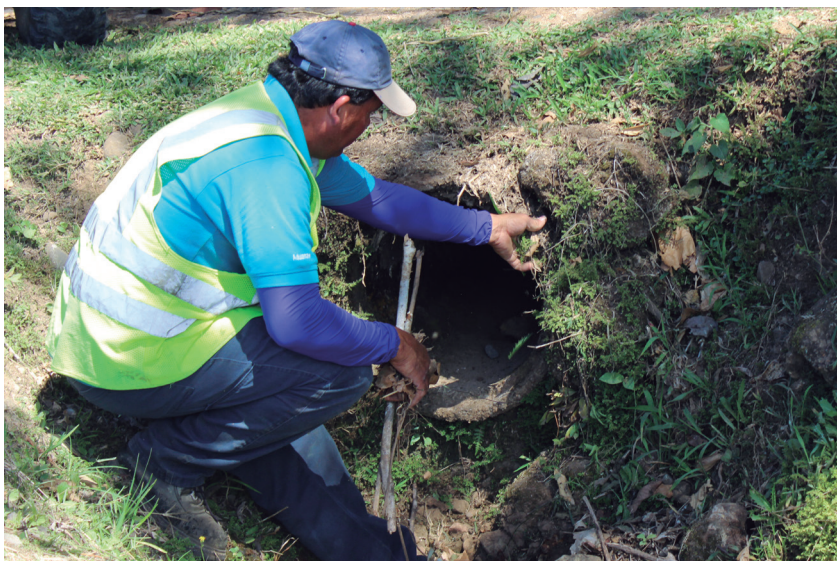
Limpieza de alcantarillas en Sitio Mata, Pavones, cantón Turrialba
