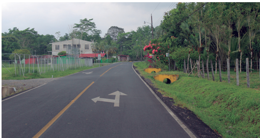
Limpieza de señales en caminos cantonales
