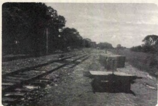
CONSTRUCCION APARTADERO EN Balsa
