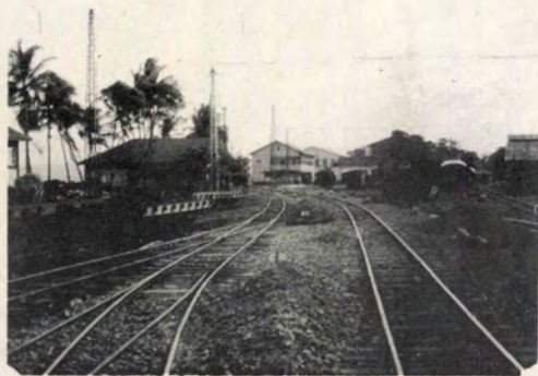
RECONSTRUCCION PATIO FERROVIARIO EN PUNTARENAS
