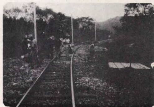
OBRAS DE MANTENIMIENTO EN TODA LA VIA
