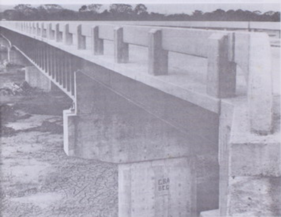
Puente sobre el Río Chirripó Carretera Limón-Siquirres
