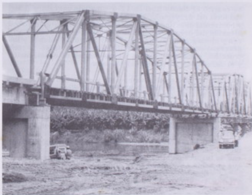
Puente sobre el río La Estrella, ubicado en el proyecto Westfalia-Penshurst.
