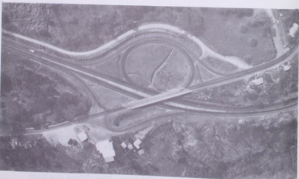
Vista aérea Intersección Atenas- Carretera "Bernardo Soto"
