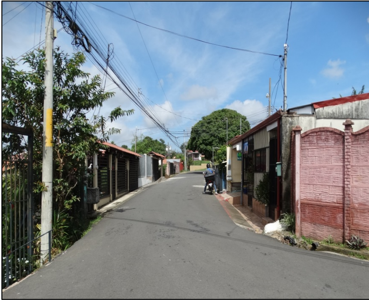
Figura N° 3 Calle en estudio sentido este – oeste, no hay señalización horizontal.
