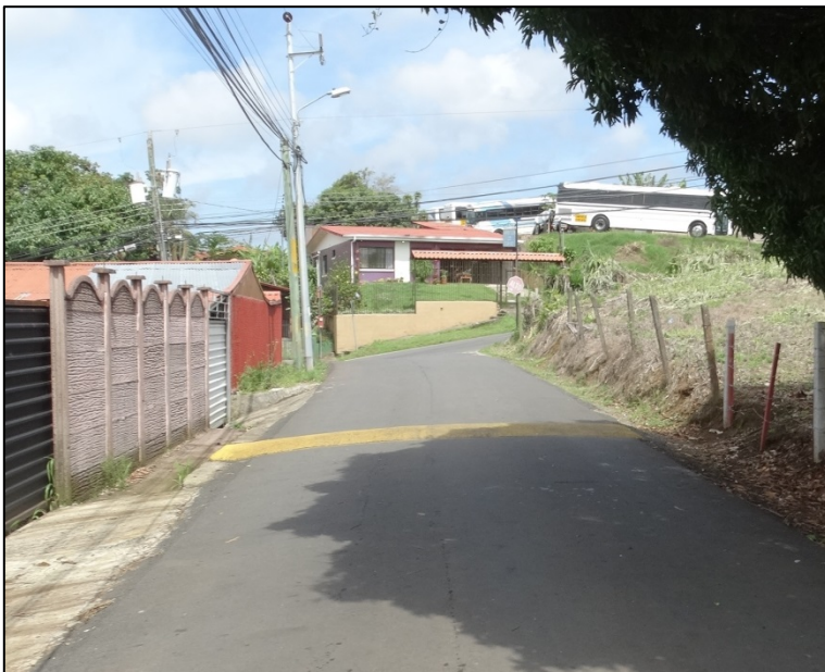
Figura N° 4 Reductor de velocidad existente, sin señalización vertical.
