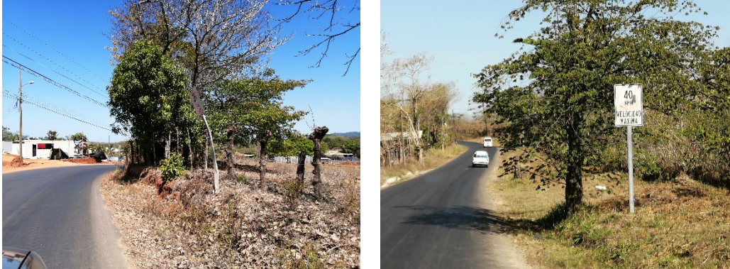
Figura N° 4 Señalamiento vertical existe sobre ruta nacional
