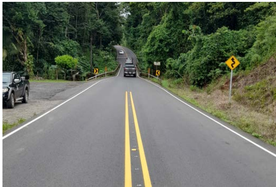
Figura 15. Puente sobre el Rio Las Delicias después de la señalización
