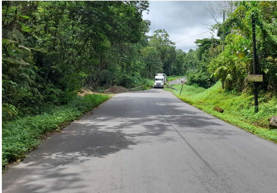
Figura 10. Puente sobre el Rio Jicarito antes de la señalización
