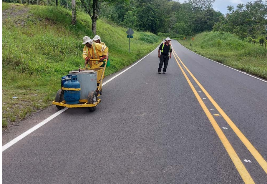
Figura 8. Instalación de captaluces en la vía
