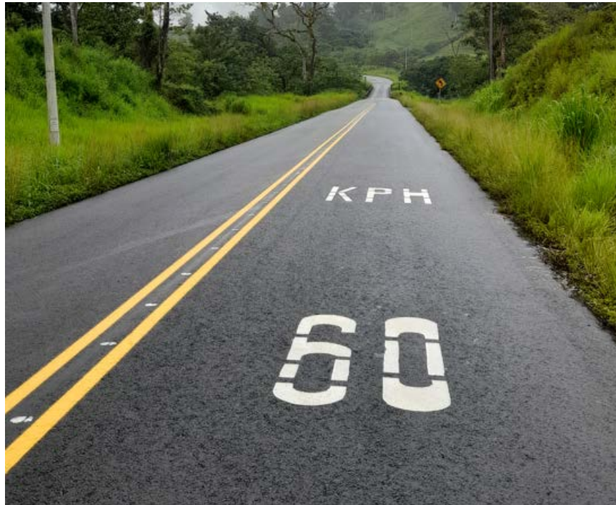
Figura 7. Demarcación de velocidad restringida en puente angosto con 60 KPH
