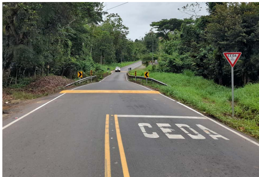
Figura 11. Puente sobre el Rio Jicarito después de la señalización
