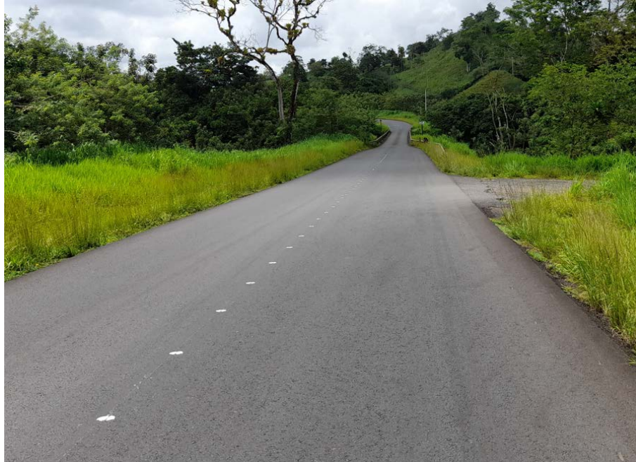
Figura 5. Trabajos de predemarcación sobre la Ruta Nacional N° 4 sección de control 21352
