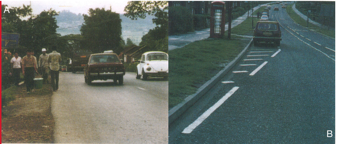
Figura II-5 A. Carencia de facilidades peatonales en distribuidor local B. Distribuidor local donde la calzada ha sido angostada a través de estacionamientos protegidos para reducir la velocidad. Nótese las aceras bien separadas
