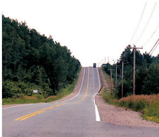
Figura II-15 Ejemplo de carril de ascenso
