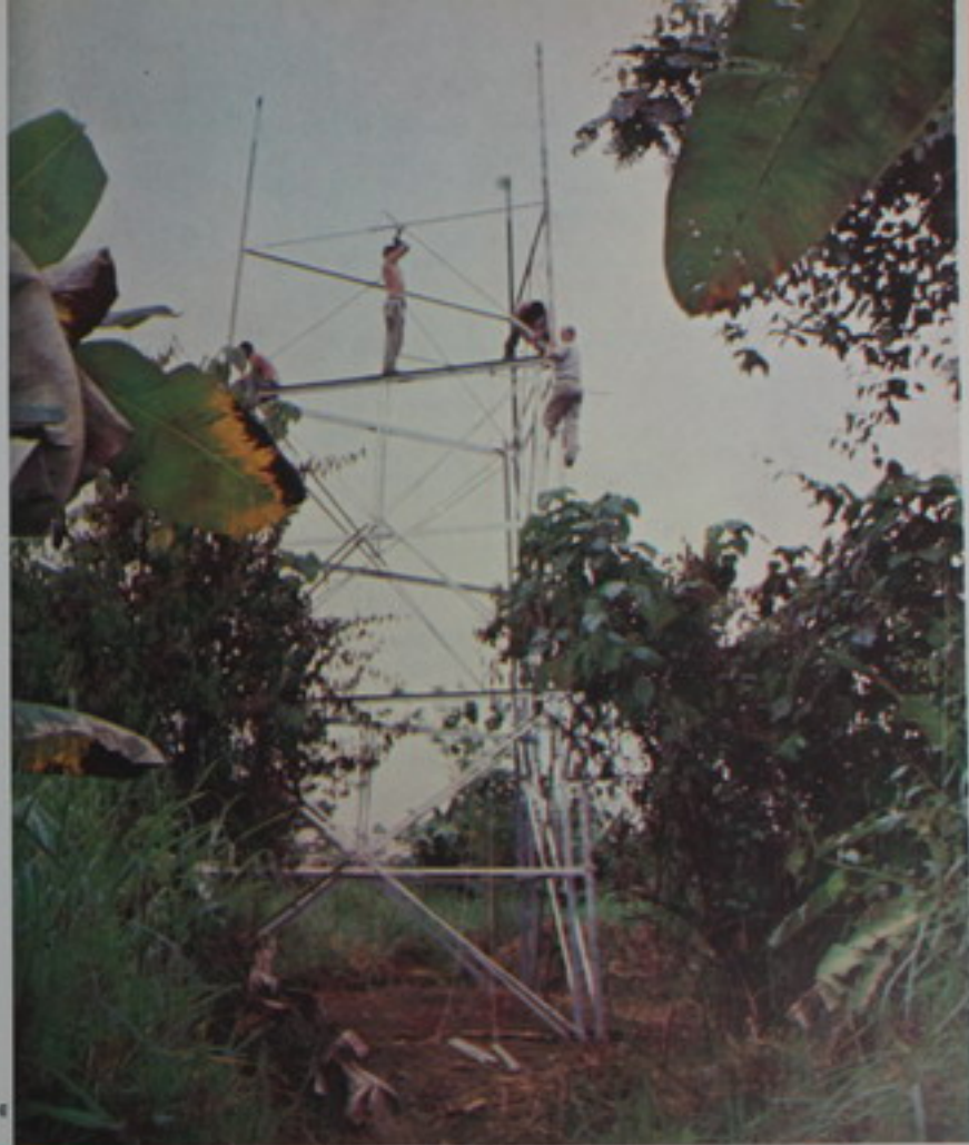
CONSTRUCCION DE TORRE DE TRIANGULACION. GUAPILES
