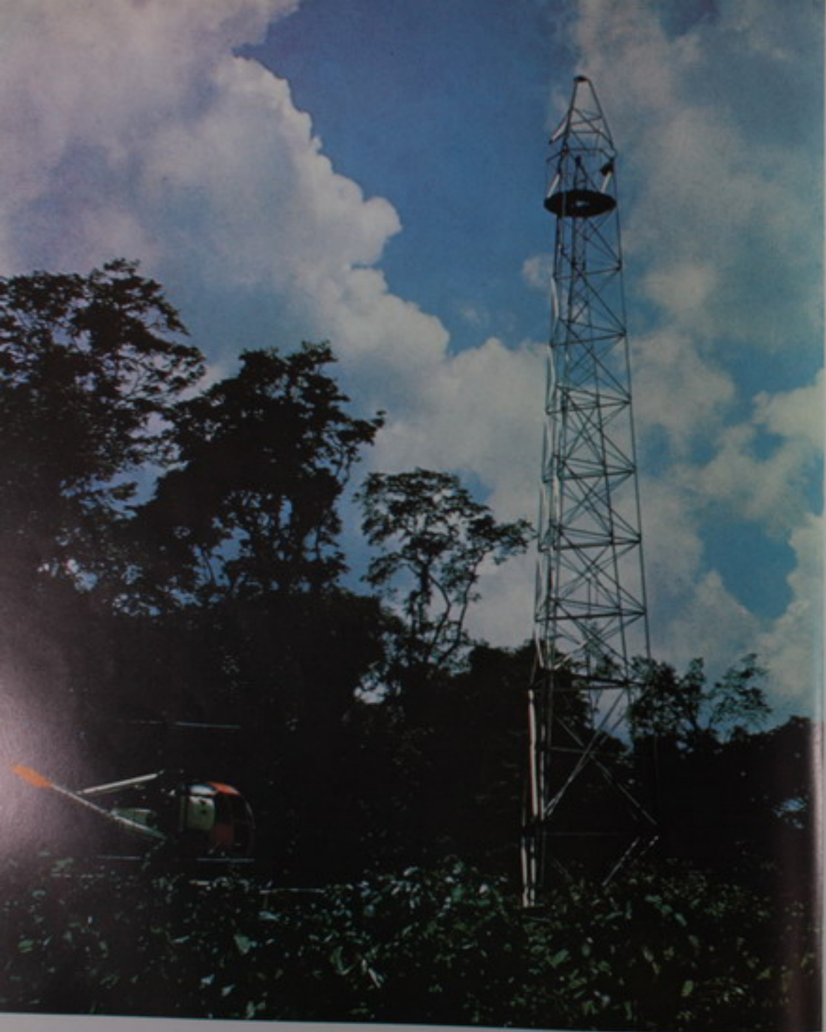
TORRE DE TRIANGULACION TERMINADA
