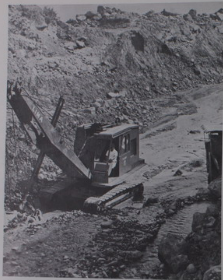
CONSTRUCCION DE DIQUES. CARTAGO
