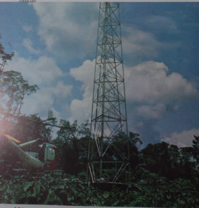
TORRE DE TRIANGULACION EN CONSTRUCCION
