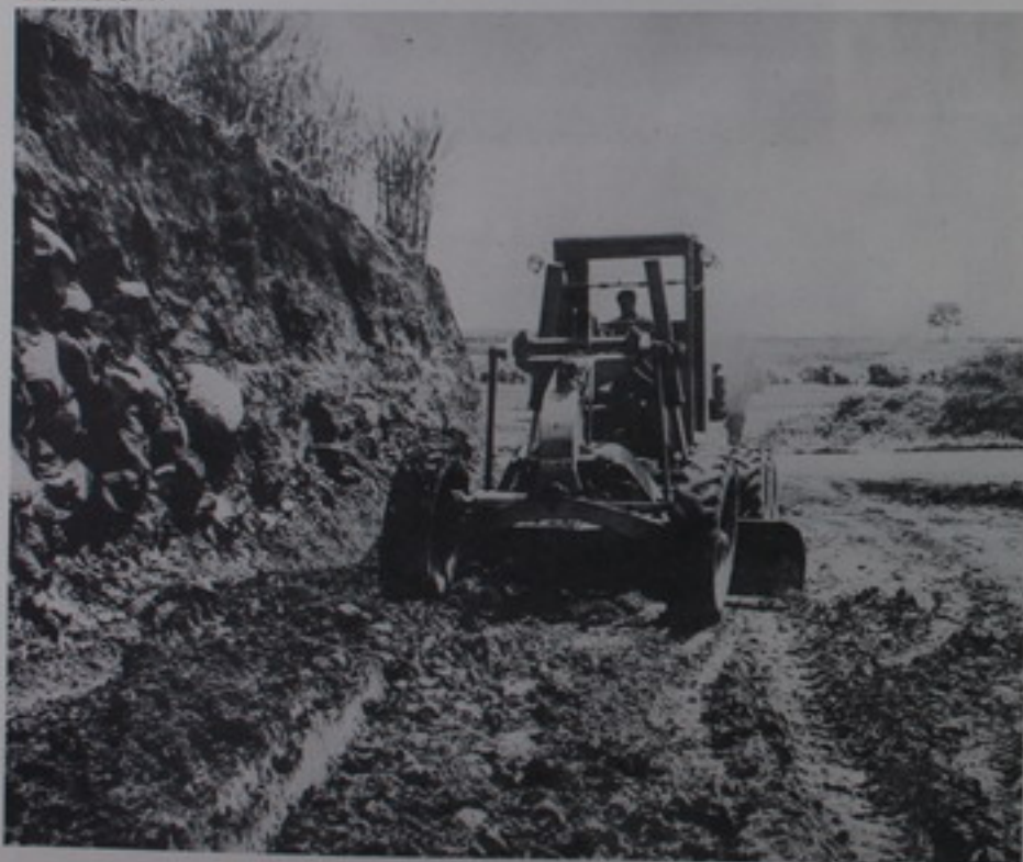
TRABAJOS DE AMPLIACION EN CARRETERA INTERAMERICANA
