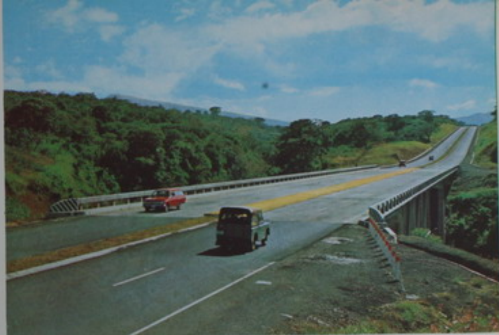
SEÑALAMIENTO Y POSTES DE SEGURIDAD EN EL PUENTE SOBRE EL RIO VIRILLA. AUTOPISTA EL COCO
