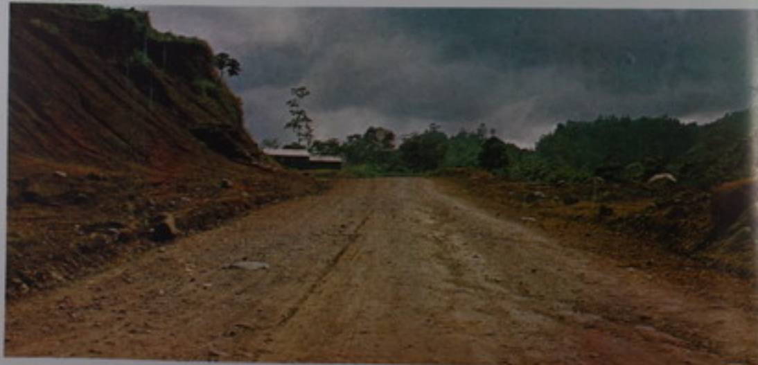
CONSTRUCCIÓN DE LA CARRETERA NACIONAL PAVONES-SIQUIRRÉS
