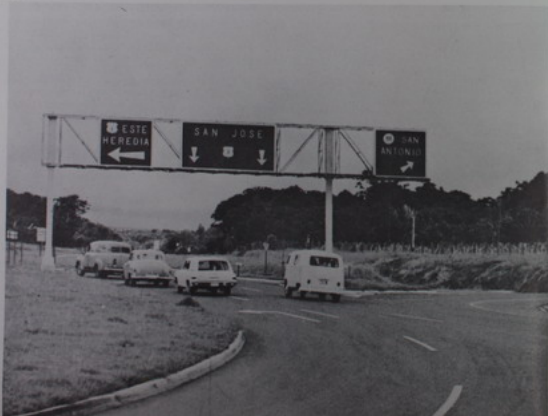
SEÑALES DE GUIA EN LA AUTOPISTA EL COCO
