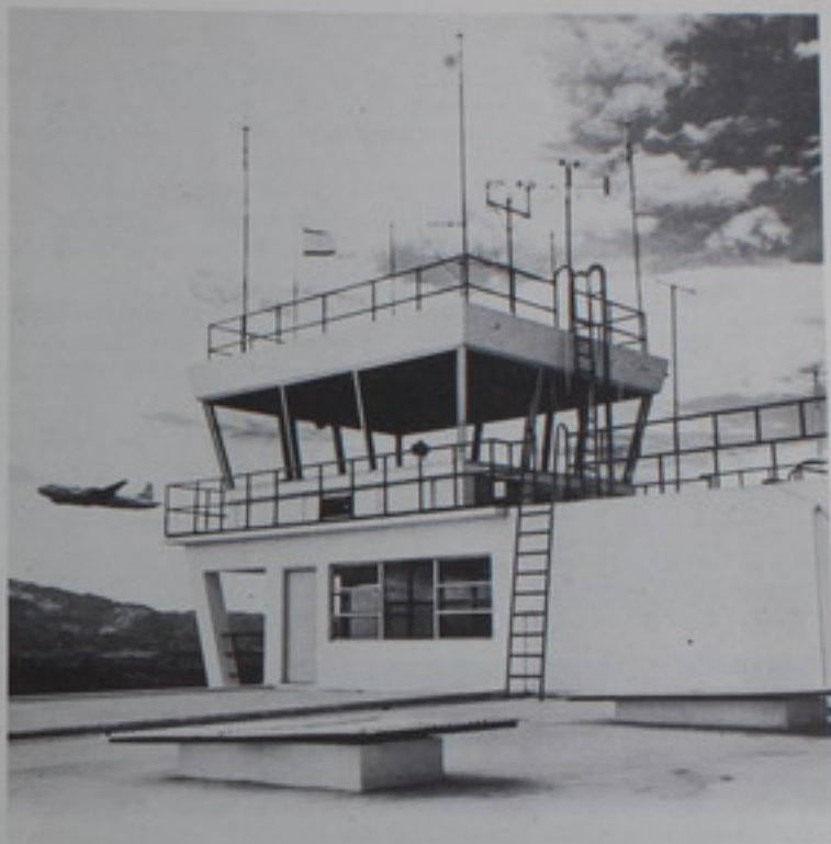
TORRE DE CONTROL. ANTENAS E INSTRUMENTOS
