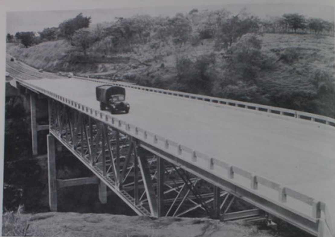
PUENTE SOBRE EL RIO VIRILLA. AUTOPISTA EL COCO
