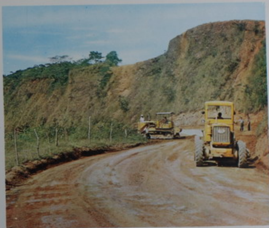
AMPLIACION Y RECONSTRUCCION DE LA CARRETERA VILLA COLON-PURISCAL
