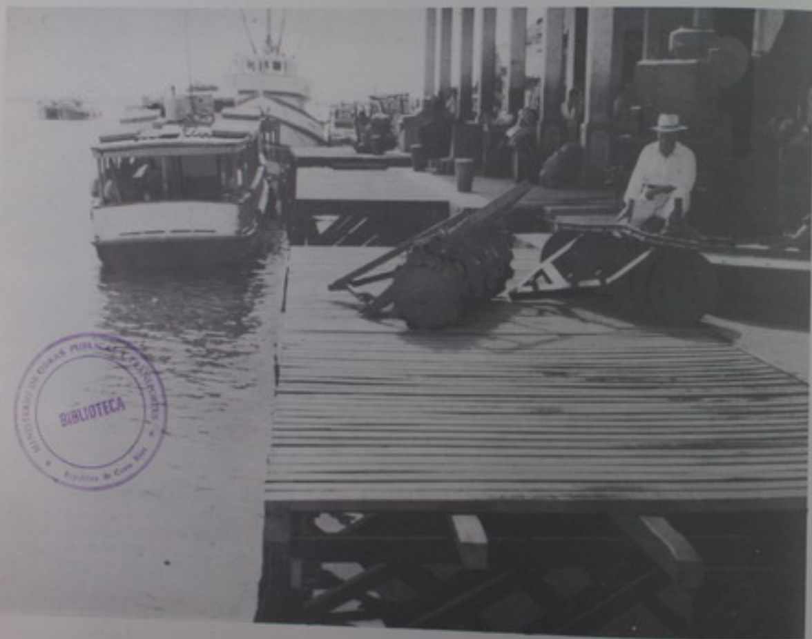
MUELLECITO DE PUNTARENAS. ACTUALMENTE EN REPARACION
