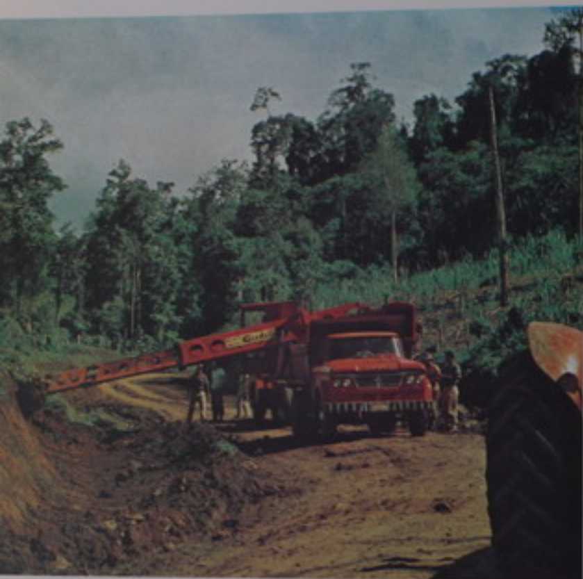
TRABAJOS EN PAVONES-SIQUIRRES
