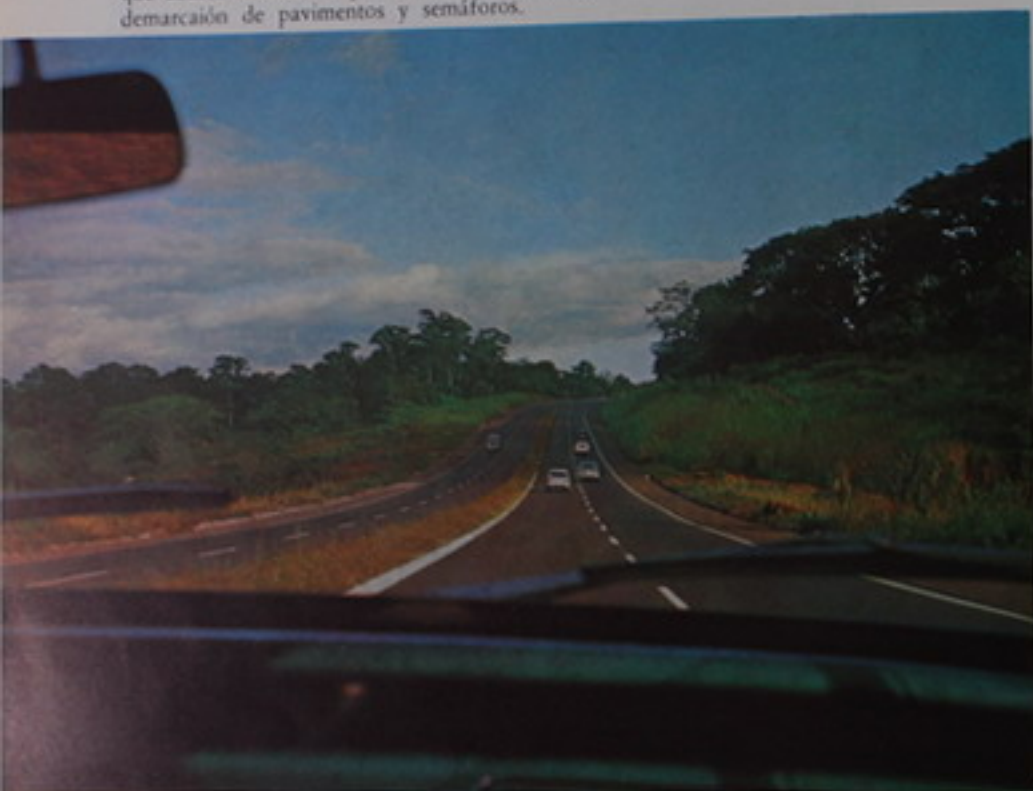
SEÑALAMIENTO EN AUTOPISTA EL COCO
