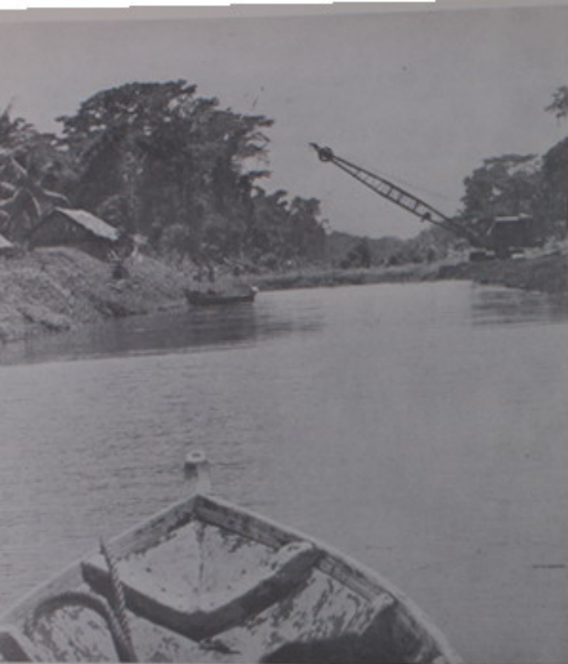
DRAGA TRABAJANDO EN LA CANALIZACIÓN DE LAS LAGUNAS DE TORTUGUERO
