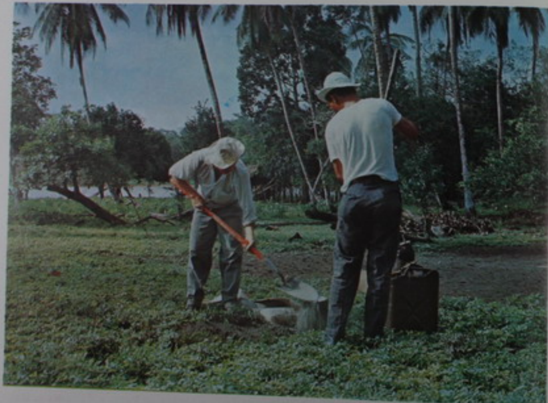
TRABAJADORES AMOJONANDO UNA LINEA DE NIVELACION SARAPIQUI-SAN JUAN-LIMON
