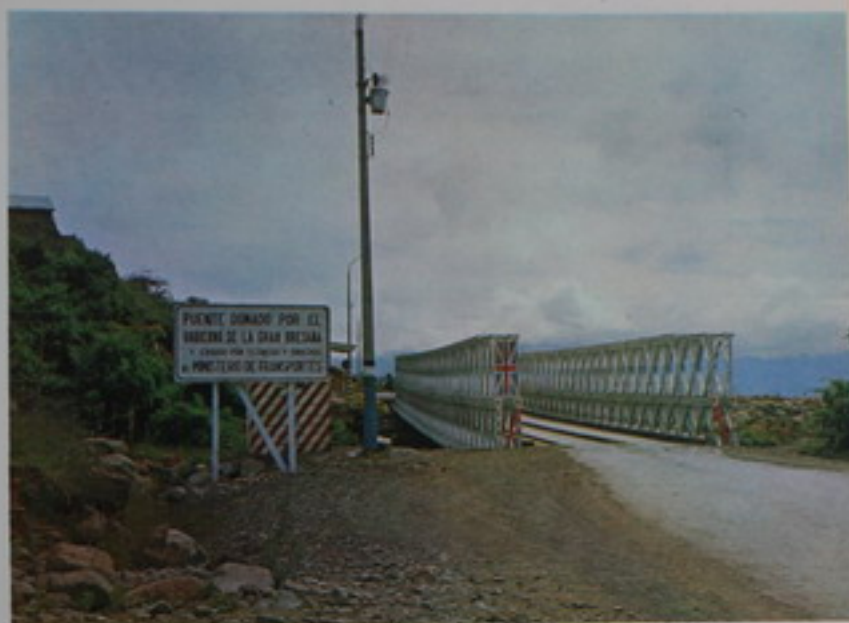
PUENTE BAILEY EN CARRETERA DE ACCESO A CARTAGO
