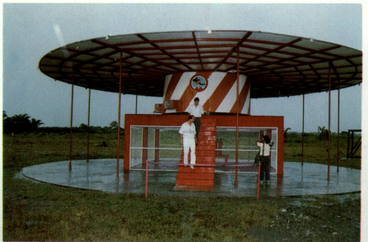
Nuevos y modernos equipos de radar.
