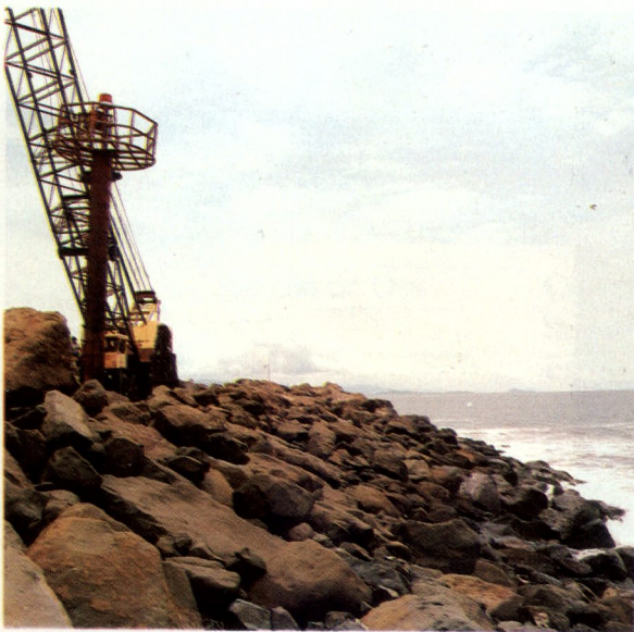
Trabajos en el rompeolas de Puerto Caldera.
