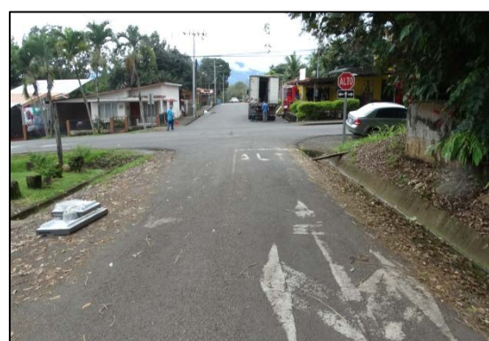
Figura N° 7 Señalización de horizontal de ALTO, ruta cantonal
