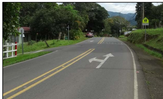
Figura N° 5. Señalamiento vertical existente, no hay acera
