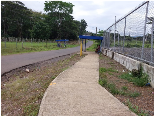
Figura 2. Calle Lagunillas, camino 6-11-022, se observan casetas de paradas de transporte público.
