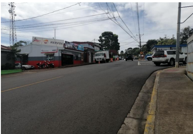
Figura 3. Condición actual de la intersección
