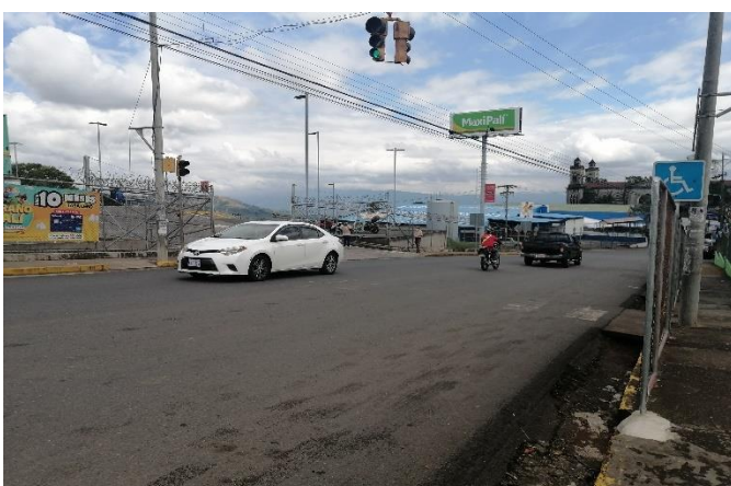
Figura 4. Condición actual de la intersección, peatonal frente a Escuela.
