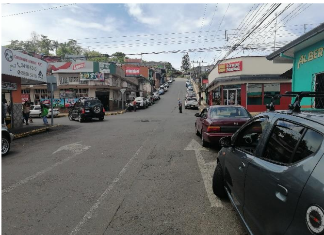
Figura 5. Condición actual de la intersección
