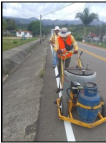
Imágenes 16 y 17. Colocación de captaluzes.
