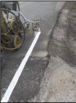
Imágenes 12 y 13. Trabajos de demarcación de la línea de borde continua blanca.
