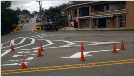
Imágenes 14 y 15. Trabajos de demarcación de letrero, flechas direccionales, islas canalizadoras y puentes.
