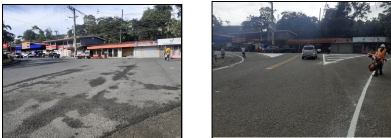
Imágenes 25 y 26. Fotografía antes y después (estación 2+000).
