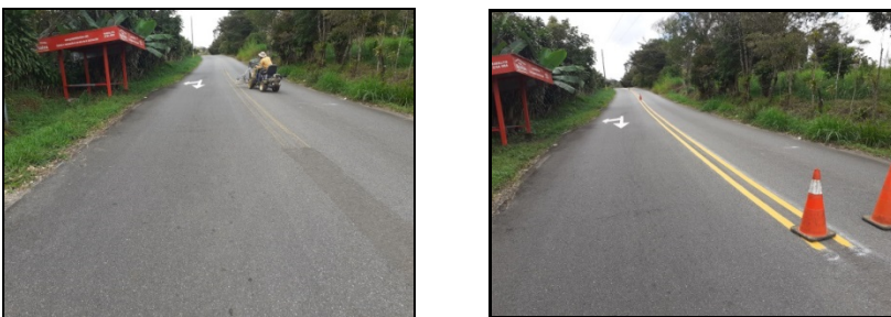
Imágenes 23 y 24. Fotografía antes y después (estación 22+450).
