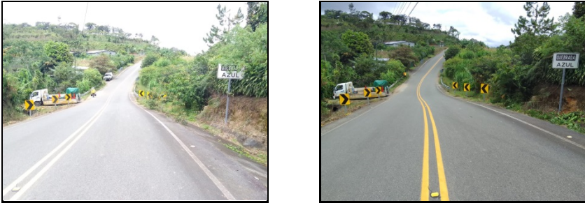
Imagen 22. Labores de mantenimiento de señales.
