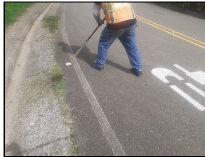
Imágenes 2 y 3. Labores de eliminación de captaluces.
