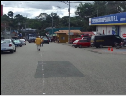
Imágenes 4 y 5. Trabajos de punteo de línea de centro.
