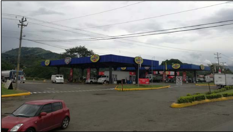
Figura 4. Estacion de servicio, comercio costado oeste de la vía.
