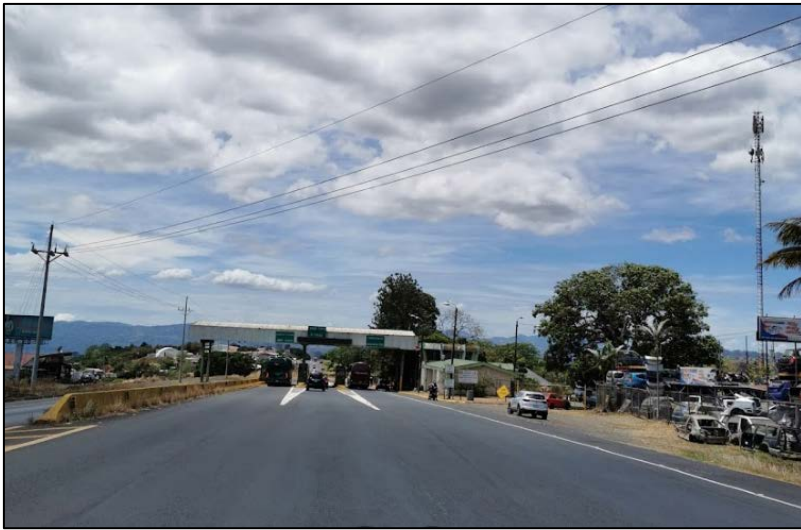
Figura 2. Peaje de Naranjo sentido norte-sur
