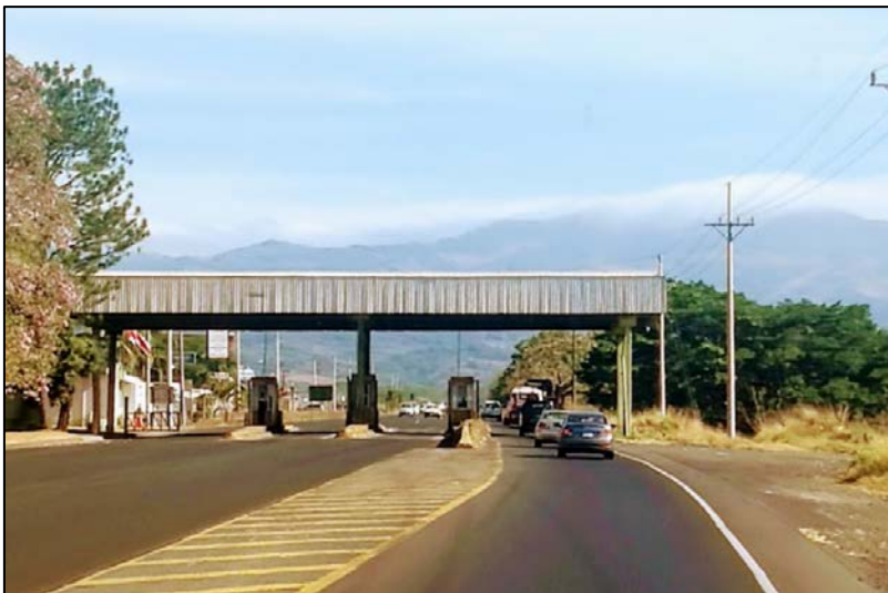
Figura 3. Peaje de Naranjo sentido sur-norte
