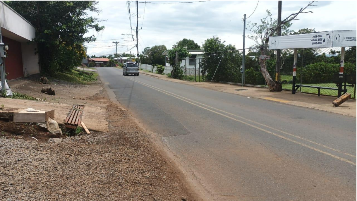
Figura 5 Caseta de bus en acceso sur intersección calle Quebradas con ruta nacional N.º 107, Tambor, Alajuela. Fuente: Osvaldo Piedra.
