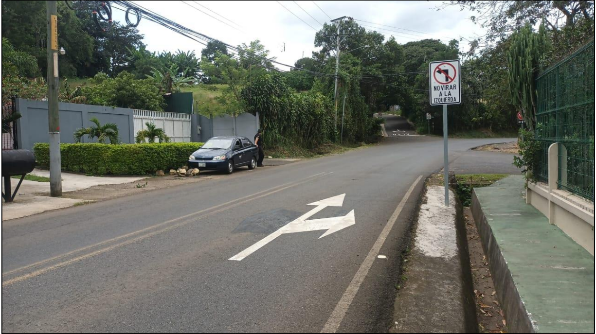
Figura 3 Intersección calle Quebradas - ruta nacional N.º 107, Tambor, Alajuela. Fuente: Osvaldo Piedra.
