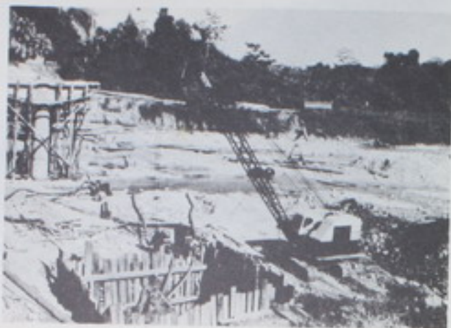
Vista del adelanto de los trabajos de construcción en el puente sobre el río Lagarto. En primer plano se ve la excavación de la Pila N° 2 y en segundo plano a la izquierda se aprecia el Estribo N° 1 completamente terminado. Proyecto 31-59-9.
