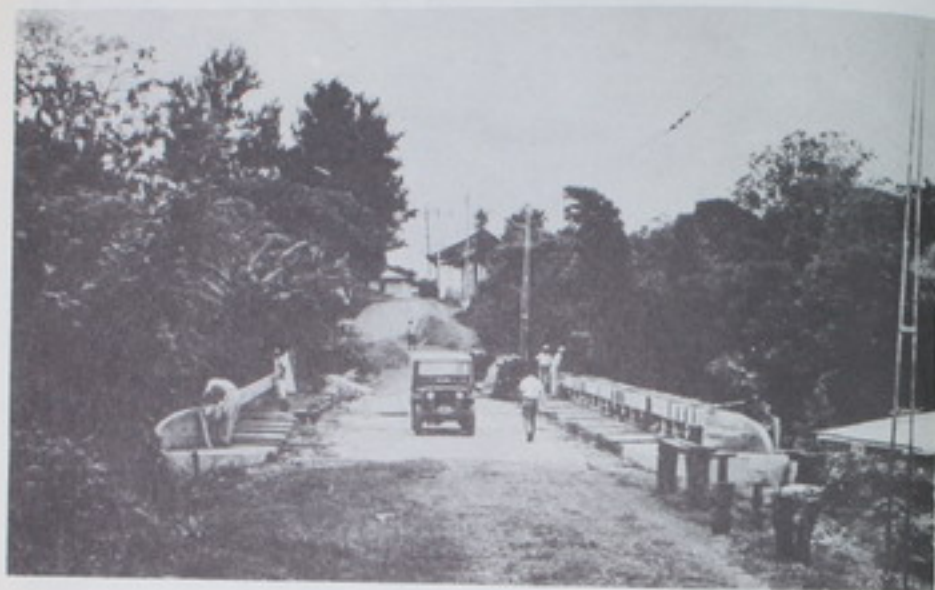
Puente sobre Rfo Segundo en Cuadrante de Barba. Este puente se construyó para dividir en tránsito de la carretera a Sarapiquí al cruzar la ciudad de Barba.
