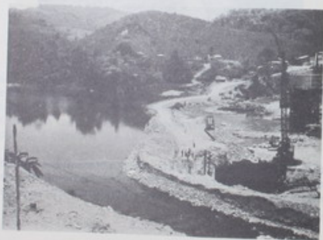
Vista del desvío de aguas en el río Térraba Superior y de los trabajos de construcción del puente. Se aprecia en la parte derecha de la fotografía, en primer plano el tablero para la excavación y colada de la Pila N° 2 y en segundo plano la Pila N° 1 completamente terminada. Proyecto 31-59-9.
