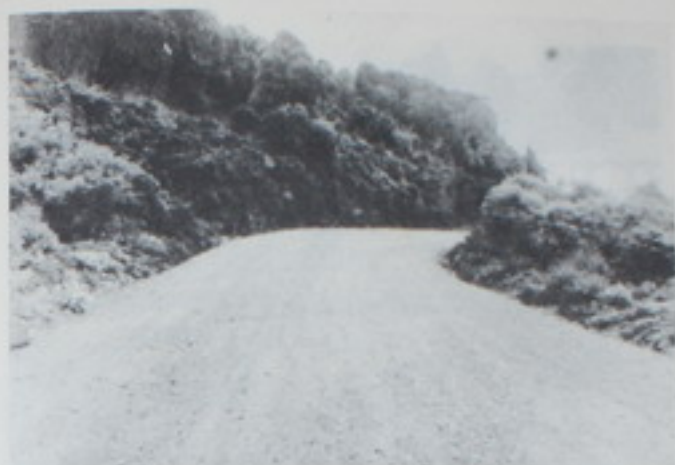
Vista de un tramo de la Carretera entre San Isidro de El General y Cartago, mostrando una sección de sub-base - en un punto cercano al Cerro de la Muerte. Proyecto 7.
