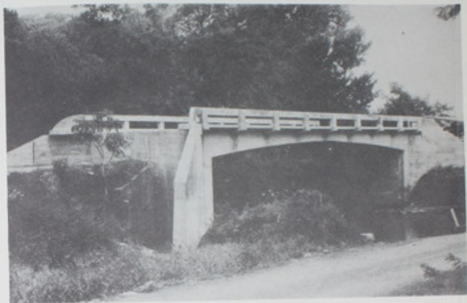
Puente sobre Río Las Palmas Carretera Liberia-Nicoya.
