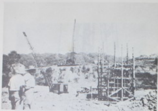
Vista del sitio de la construcción del puente sobre el río Térraba Superior. En primer plano la armadura de la Pila N° 2 y al fondo la máquina hincadora de pilotes lista para trabajar en el Estribo N° 1. Proyecto 31-59-9.
