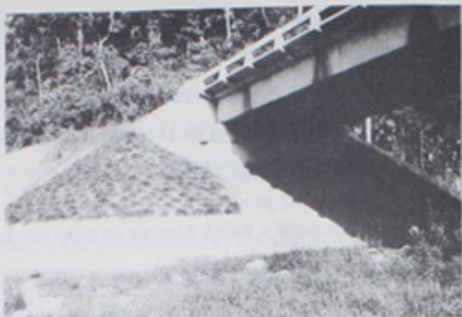
Vista del puente sobre el río Convento, uno de los cuatro construidos en el Proyecto 75-56-5.
