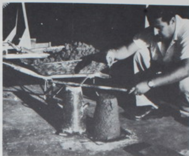
Diseño de mezclas de hormigón. Medida de la docilidad.
