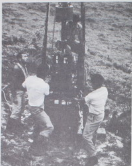
Equipo de perforación trabajando
