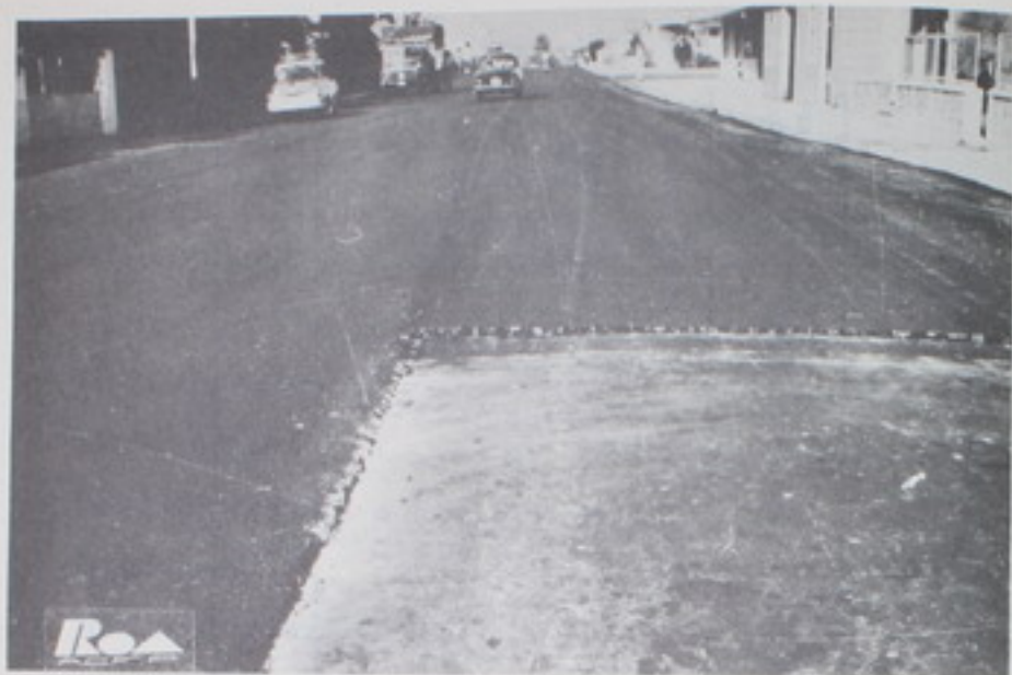
1. CARRETERA SAN JOSE - GUADALUPE
