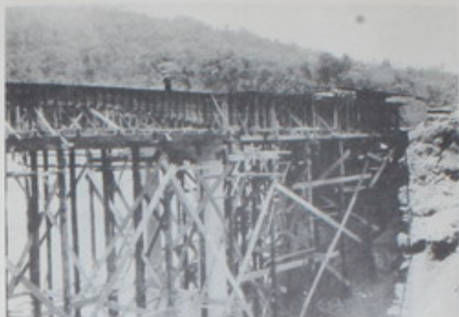
Vista del puente en construcción sobre el río Zapote que muestra la obra falsa para la superestructura. Proyecto 31-59-9.
