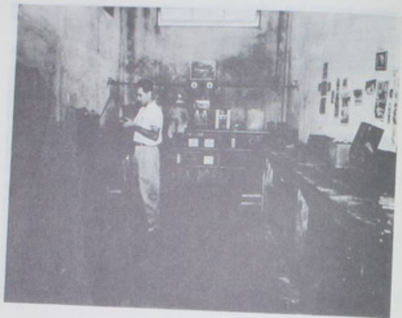
En esta Sección se hace la reparación de baterías. Uno de los o perarios mide el voltaje a una batería cargada.
