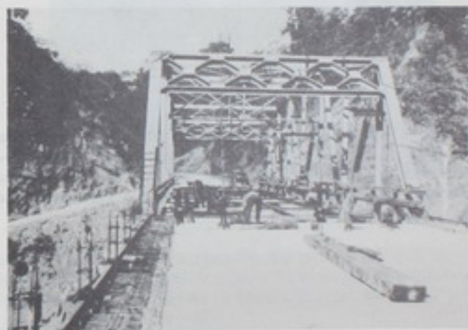
Vista general del puente sobre el río Coto tomada desde el Estribo N° 2, mirando la estructura de acero que sal va un tramo de 150 pies de luz. Se aprecian los trabajadores efectuando la remachada de las vigas para el piso. Proyecto 31-59-9.
