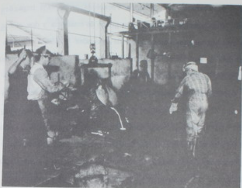
Operarios de la Sección de Fundición proceden al vaciado del material dentro de los moldes. Operación bastante difícil y peligrosa. Un error puede ser fatal.
