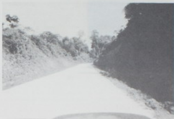
Vista de una sección de sub-base terminada, Proyecto 75-56-6.
