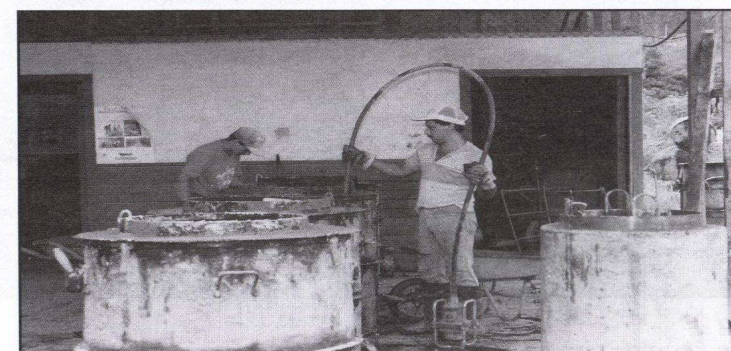
Figura 22 Vibración del concreto.
