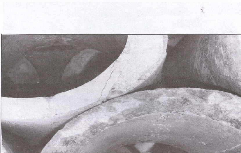
Figura 27 Daños por acomodos inadecuados.
