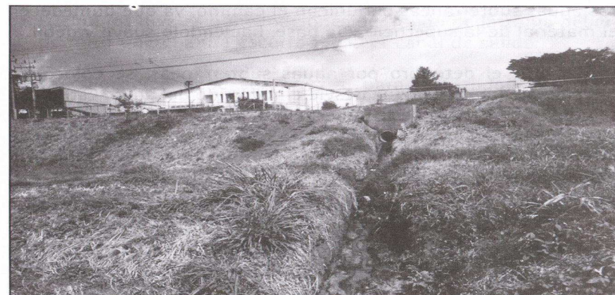
Figura 10 Canales de salida de un camino
