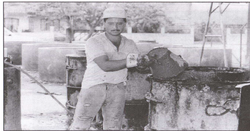
Figura 20 Relleno de un molde con concreto usando una cubeta.
