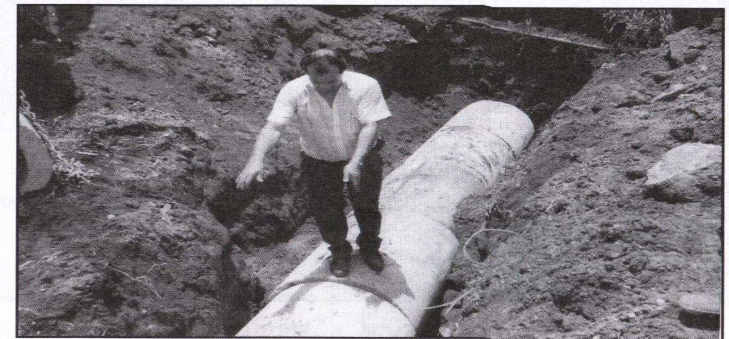
Figura 12 Alineación de tubería
