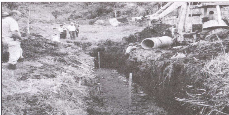
Figura 9 Colocación de una alcantarilla en la zanja
