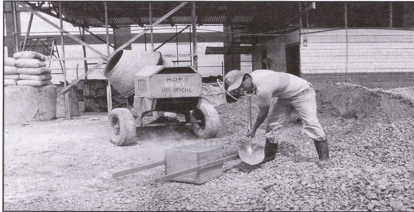
Figura 14 Cajón de madera para medir los materiales, de 30 x 30 x 30 cm.
