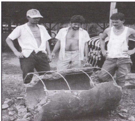
Figura 21 Deterioros por procedimientos inadecuados en la preparación de la mezcla y en el patio de curado.
