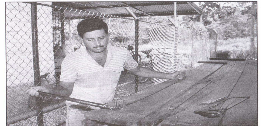
Figura 16 Doblado de los extremos de los parales utilizando una grifa.
