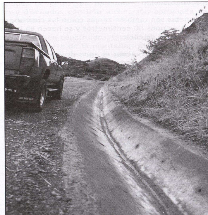
Figura 4 Cuneta de un camino revestida de concreto
