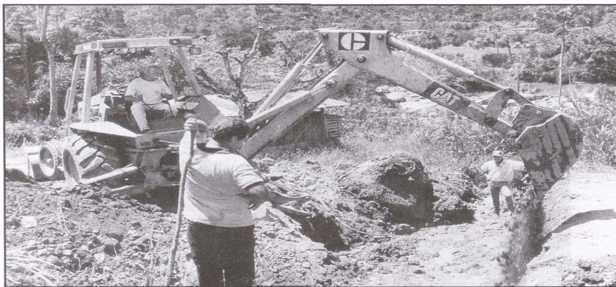
Figura 13 Preparación de zanja para instalar alcantarilla.
