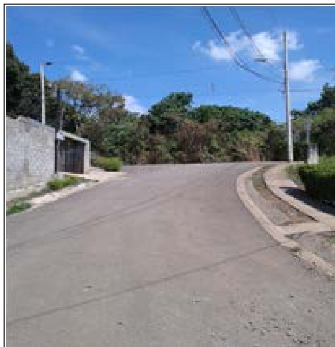
Figura N°2. Carpeta en buen estado, aceras en ambos costados
