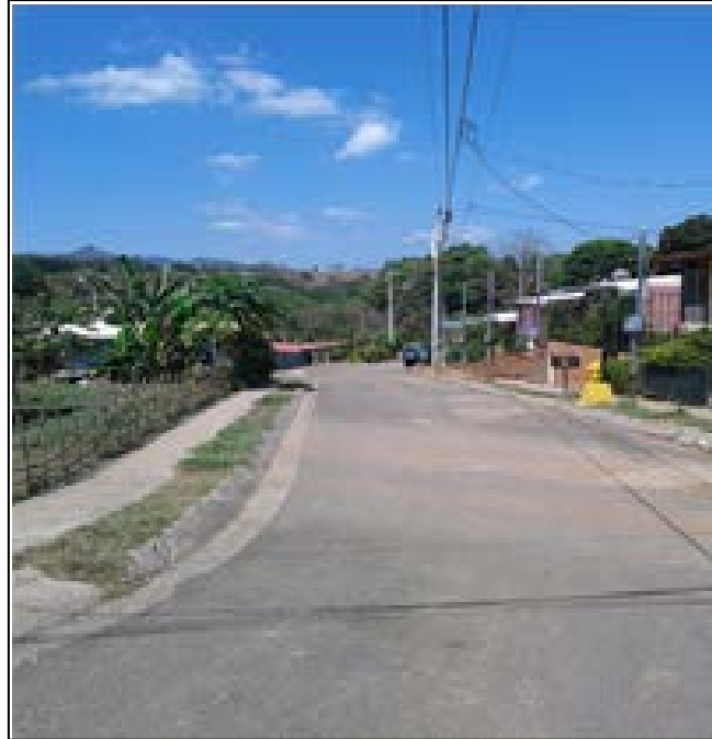
Figura N°3. Inexistencia de señalamiento vial
