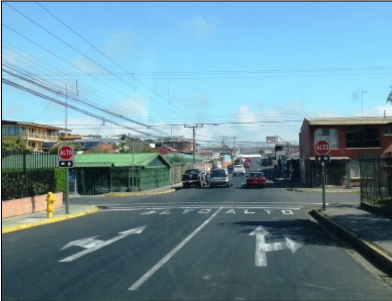
Figura 3. Calle en estudio, sentido sur – norte, con aceras, cunetas y señalización vial
