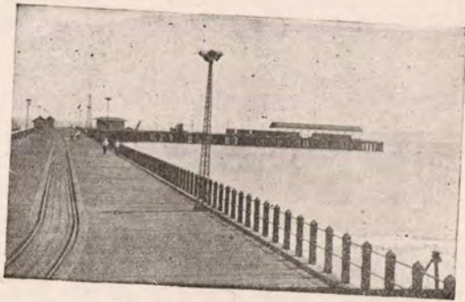
Muelle de Puntarenas
