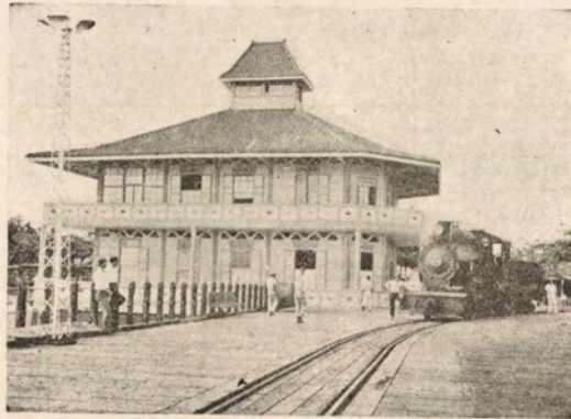
Casa de la Administración del Muelle
