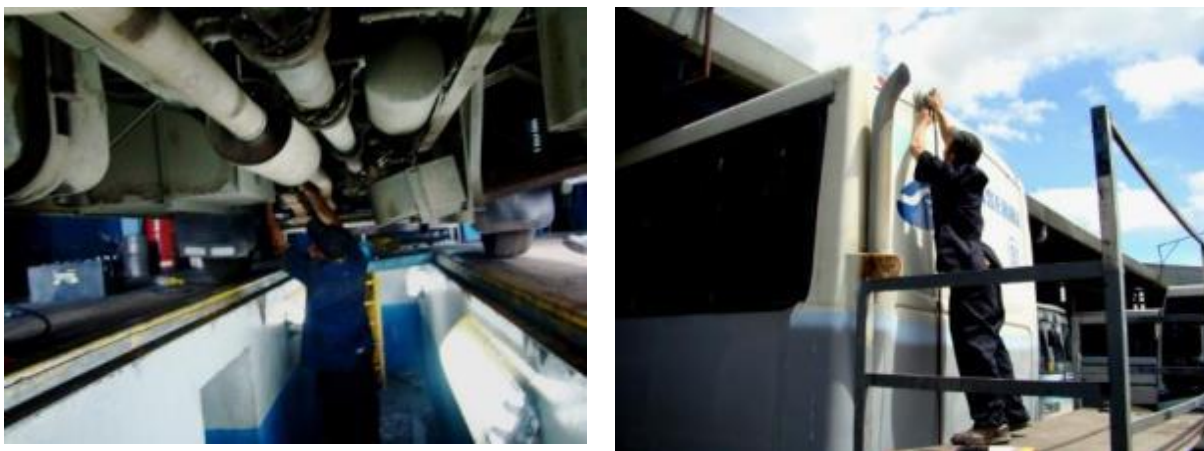
Foto 113. Zona de mantenimiento
