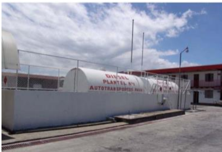
Foto 108. Zona de Abastecimiento
