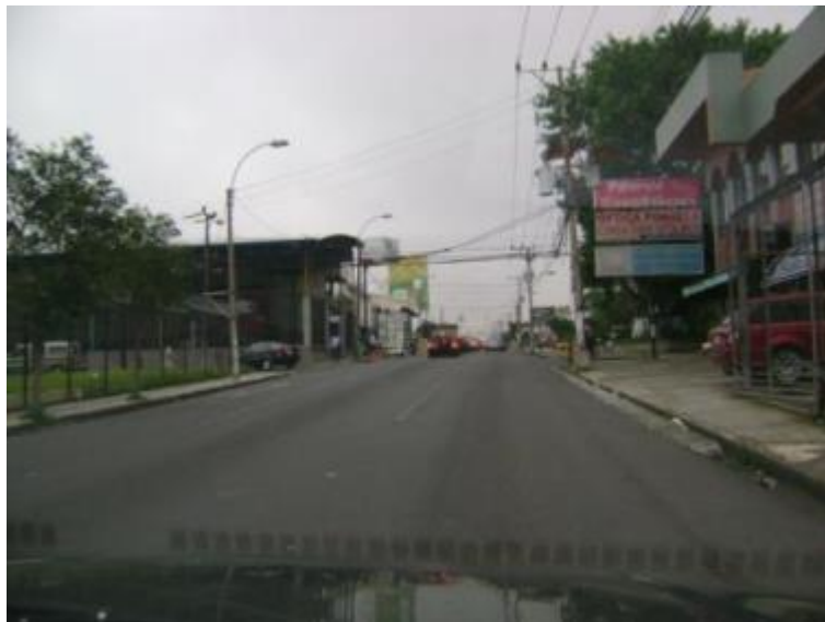
Foto 45. Avenida 63 por Calle 2 – Parque Tibas
