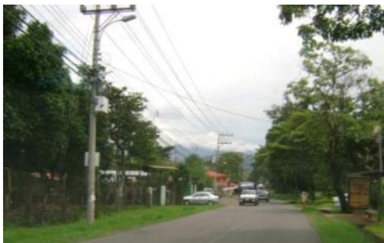
Foto 72. Vía Calle Vieja
