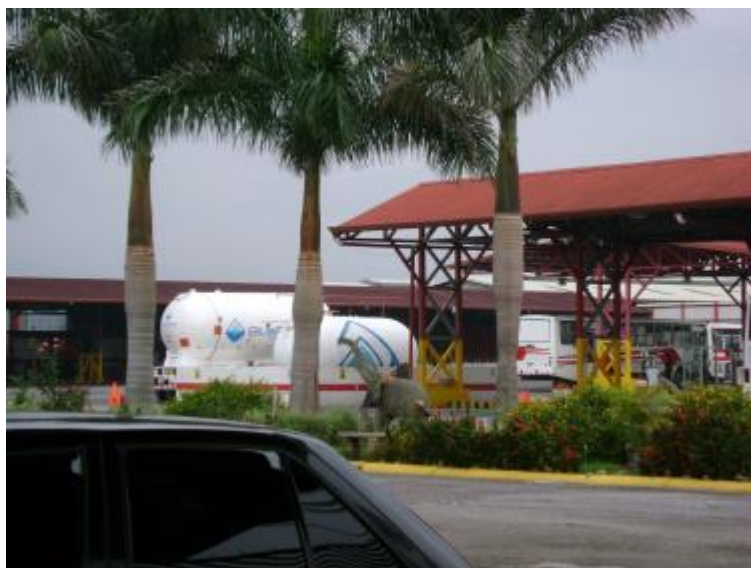
Foto 106. Zona de Abastecimiento plantel Pavas
