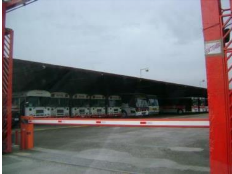
Foto 56. Terminal de Pavas
