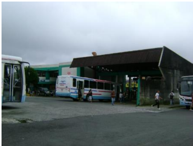
Foto 103. Terminal de Coronado. Vista posterior.
