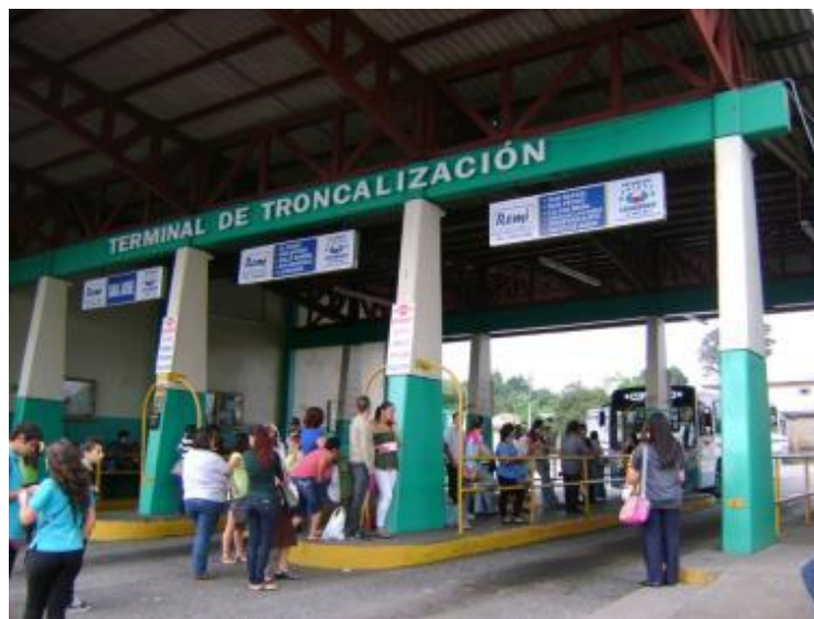
Foto 102. Detalle rampas de servicio. Terminal de Coronado.
