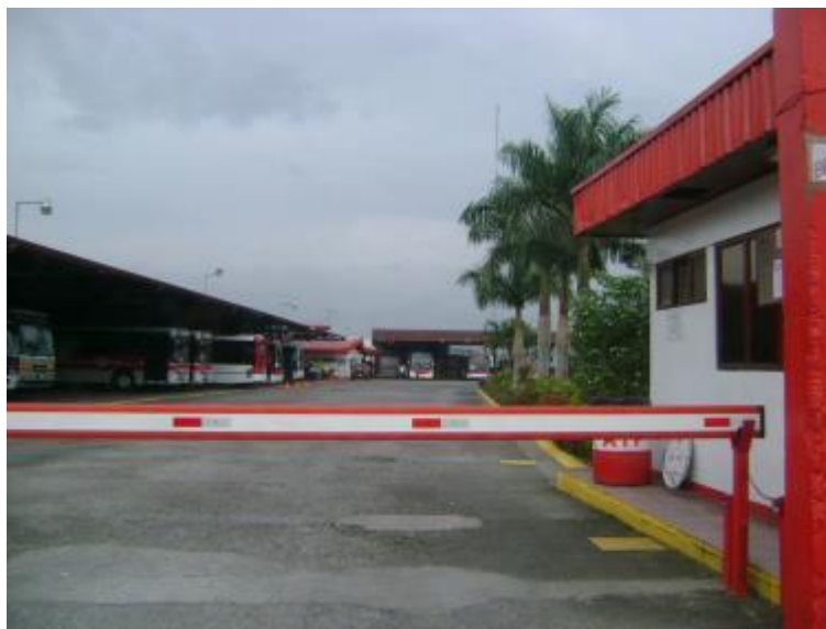
Foto 105. Entrada Plantel de Pavas
