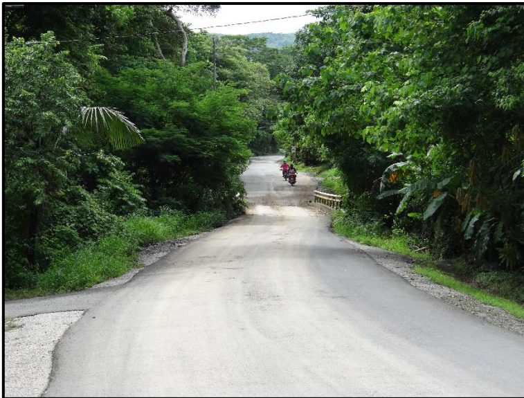
Imagen N° 2. Tratamiento superficial bituminoso en la zona.
