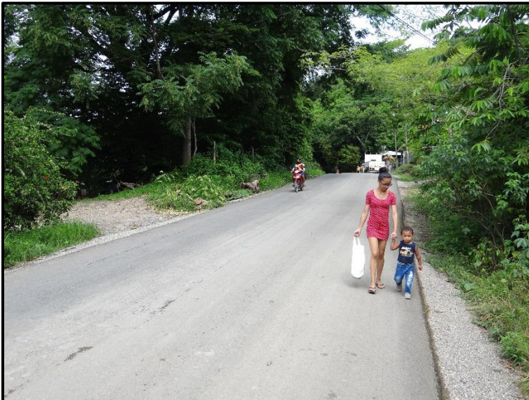
Imagen N° 4. Falta de acera.
