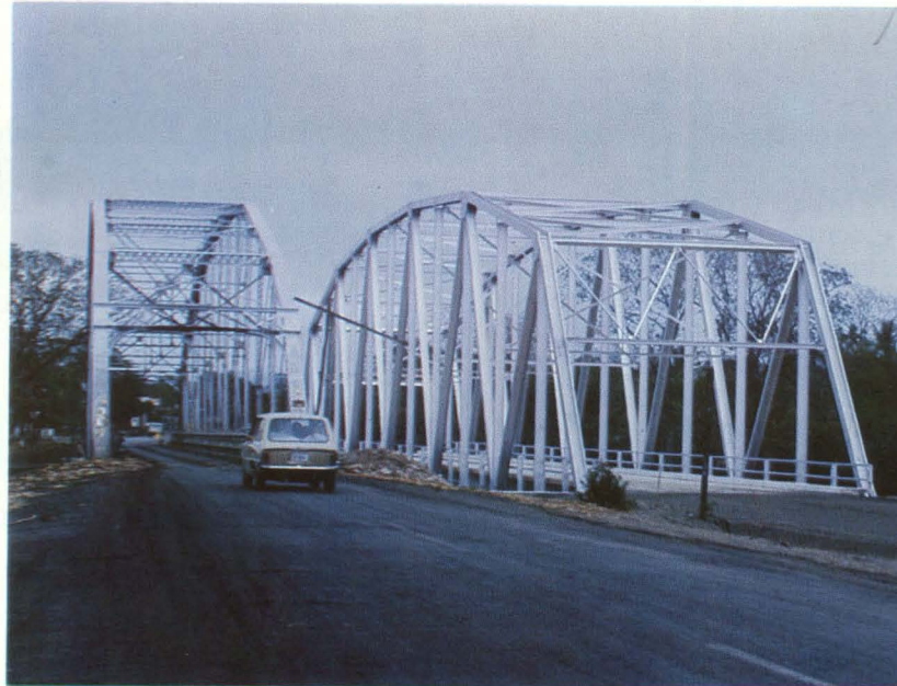
El viejo y nuevo puente sobre el río Tempisque.
