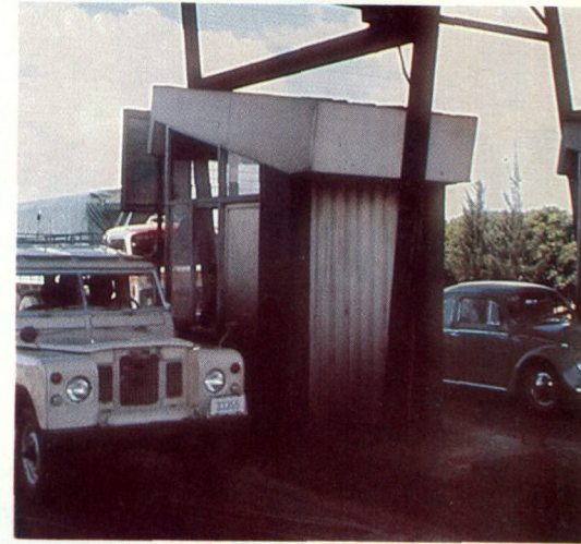
Casetas de peajes en carretera San José-Tres Ríos.
