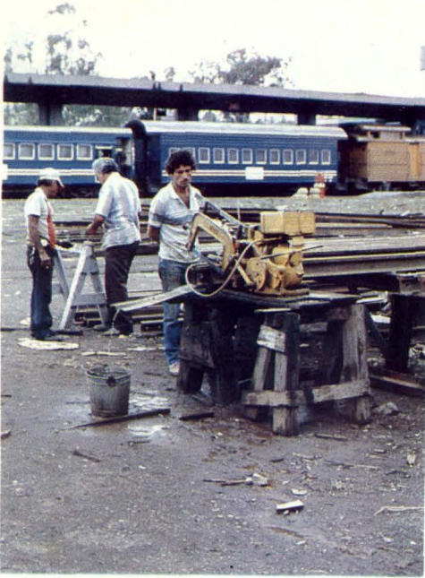
Obreros en trabajo de reparación.
