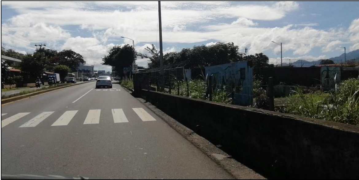
Figura 4. Sección con paso peatonal no semaforizado sin acera en el extremo sur, frente a Parroquia Nuestra Señora de Loreto, Pavas, San José. Fuente: Propia.
