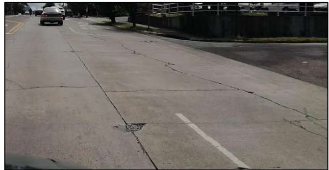
Figuras 2 y 3. Daños y grietas en secciones de calzada Ruta Nacional N° 104, Pavas, San José. Fuente: Propia.
