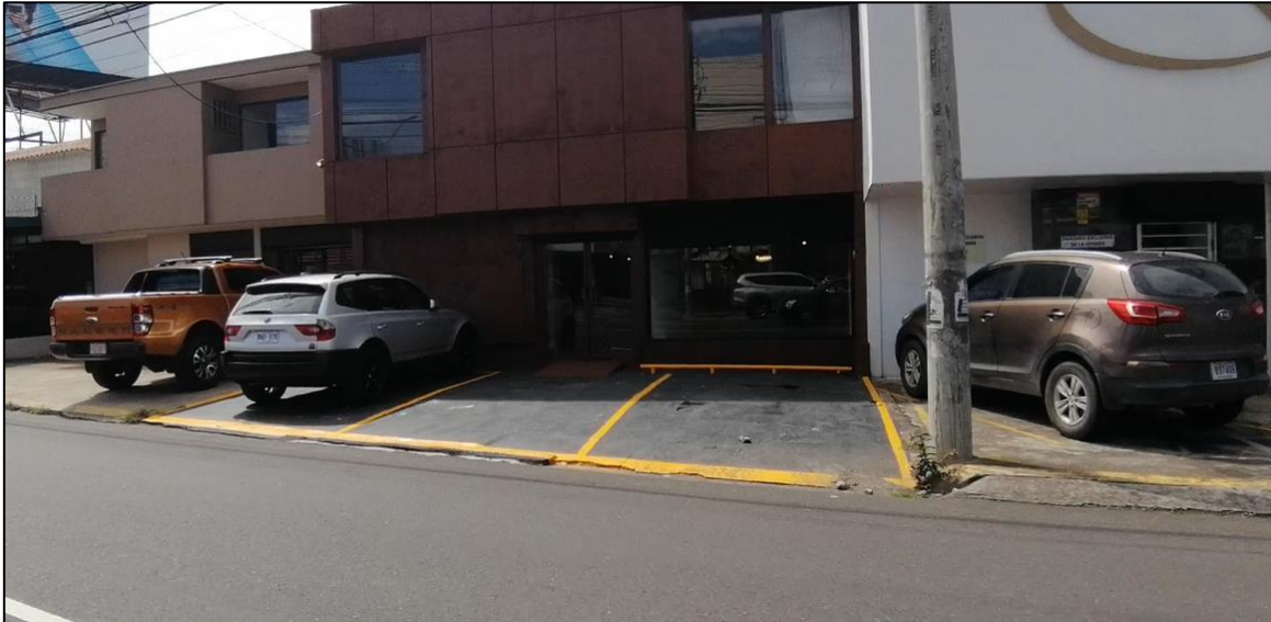
Figura 7. Demarcación inadecuada en aceras que obstruyen el paso de peatones cuando se estacionan los vehículos, Ruta Nacional N° 104, Pavas, San José. Fuente: Propia.
