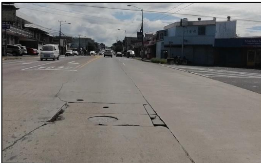
Figuras 2 y 3. Daños y grietas en secciones de calzada Ruta Nacional N° 104, Pavas, San José. Fuente: Propia.
