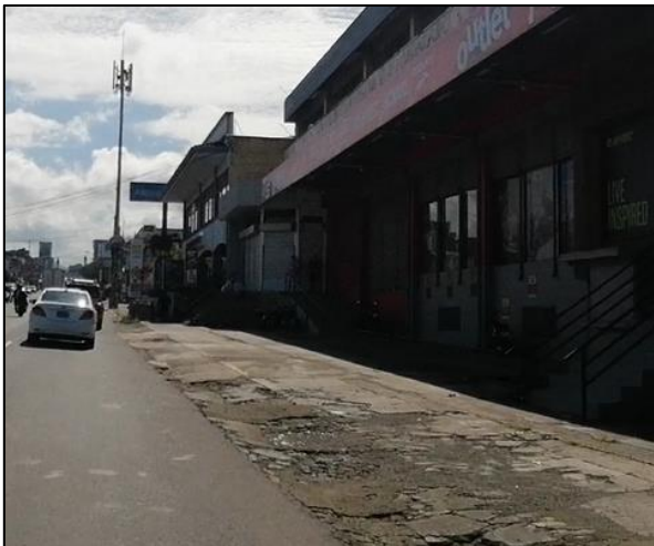
Figura 8. Varias aceras en mal estado y alcantarilla sin tapas frente a tercera casa al noroeste de Casa de Empeños La Cueva, Ruta Nacional N° 104, Pavas, San José. Fuente: Propia.
