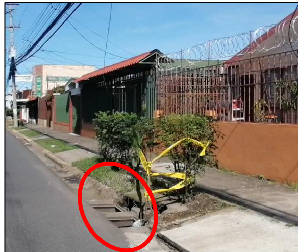
Figura 8. Varias aceras en mal estado y alcantarilla sin tapas frente a tercera casa al noroeste de Casa de Empeños La Cueva, Ruta Nacional N° 104, Pavas, San José. Fuente: Propia.
