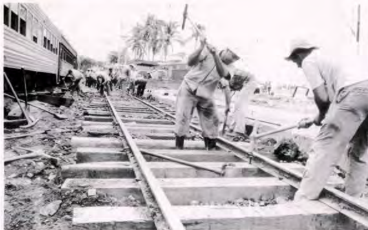
Cuadrillas en acción. Varias cuadrillas de la vía del Ferrocarril al Pacífico, en acción cuando procedían a renovar los durmientes que sostienen los rieles al paso de los trenes.
