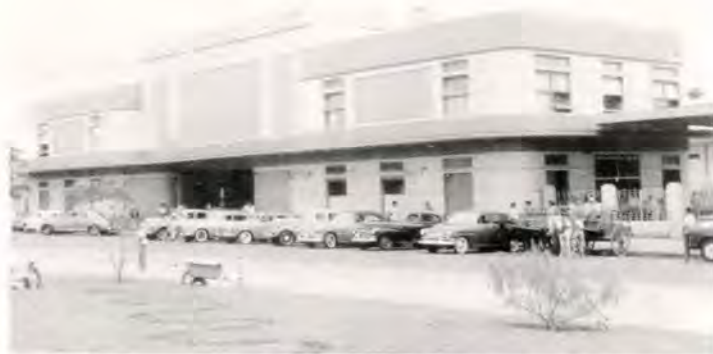
Estación Central del F.E. al P. Este es el edificio principal, donde se alojan las oficinas centrales del ferrocarril eléctrico al Pacífico. La sólida construcción de este edificio, fue hecha hace más de 20 años y desde entonces sirve como epicentro de las actividades ferrocarrileras y portuarias del Pacífico de nuestro país.
