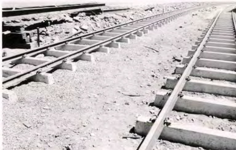
Mejoras en la vía Férrea. He aquí como habrá de quedar en poco tiempo la vía férrea a Puntarenas, cuando sean cambiados los soportes de la vía. La obra se ha emprendido con la finalidad de lograr una mayor estabilidad y confort a los pasajeros, así como duración en la vida de las piezas que se están cambiando.
