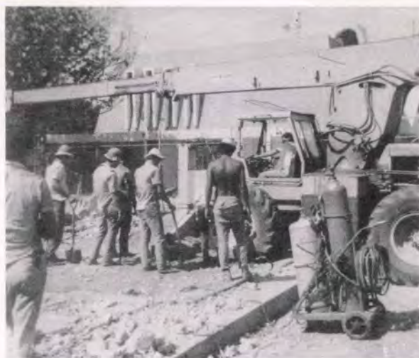
Cuadrilla de Demolición. Esta foto corresponde a los trabajos de demolición de la casa de la agencia en Puntarenas, cuando era demolida por trabajadores de la Sección Cuarta de Vía de Puntarenas. Aparecen los señores Luis Raul Jiménez Castro, Javier Sandoval Arias, Gerardo Brenes Mejía, Heriberto Morales Alvarado, José M. Cordero Chacón y Fernando Araya Mora, con parte del equipo utilizado en su dura labor.
