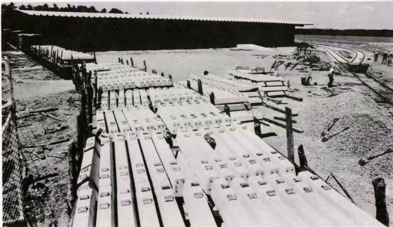
Cientos de Traviesas. Estas son las traviesas que están siendo fabricadas en la Fábrica de Productos de Concreto del País, para cambiarlas por las de madera que durante muchos años han venido siendo usadas para sustentar los rieles del Ferrocarril al Pacífico. Estas piezas son más consistentes y duraderas, además de que brindan un viaje más placentero y seguro al viajero, por lo que se están prefiriendo en la actualidad.
