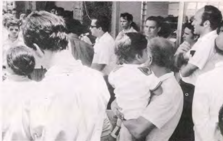
Terminal del F.C. en Puntarenas. El Gerente General del Instituto de Puertos, Ing. Rafael París, al fondo, de camisa blanca y anteojos oscuros, habla en Puntarenas, durante los actos de inauguración de varias obras construídas por esta institución en aquél puerto. Destacan en la foto también, el Obispo de Tilarán y Puntarenas, Monseñor Román Arrieta, de espaldas, el Ministro de Obras Públicas y Transportes, Ing. Rodolfo Silva, alto después de Monseñor Arrieta.
