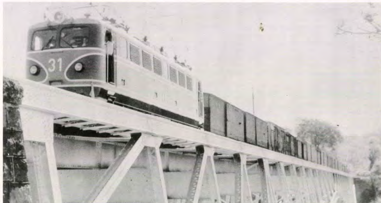
Puente sobre el río Grande. Esta es la estructura de acero del Puente sobre el río Grande, soportando el paso de un convoy de varios carros de nuestro Ferrocarril. Este puente fue construido a principios de siglo con un valor de alrededor de 200.000 pesos oro y aún sigue prestando valiosísimos servicios en nuestro sistema ferroviario.
