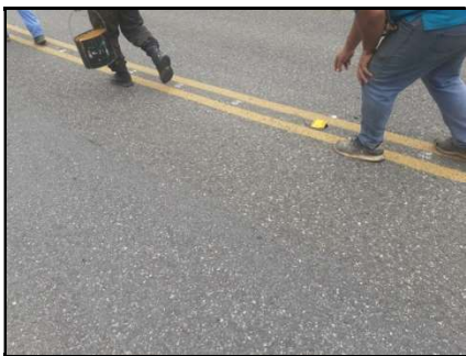
Figuras 14 y 15. Labores de instalación de captaluces.
