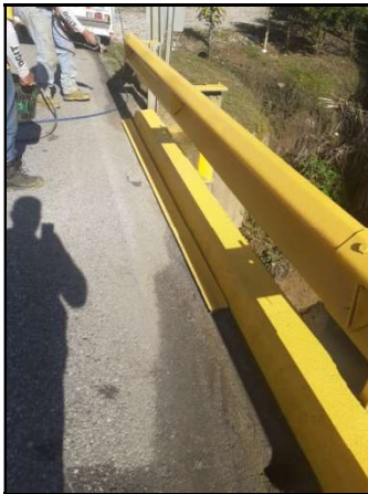
Figuras 16 y 17. Labores de demarcación de llega a puentes.
