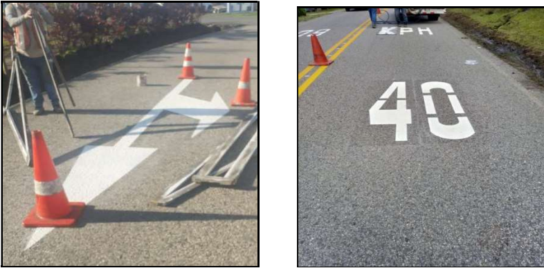
Figuras 12 y 13. Labores de demarcación de figuras.
