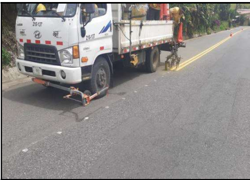
Figuras 37 y 38. Labores de demarcación de línea de centro.
