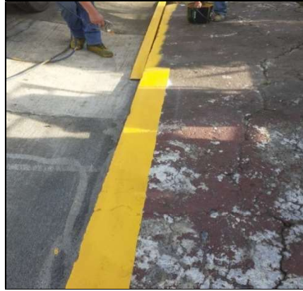
Figuras 20 y 21. Labores de demarcación de cordón amarillo
