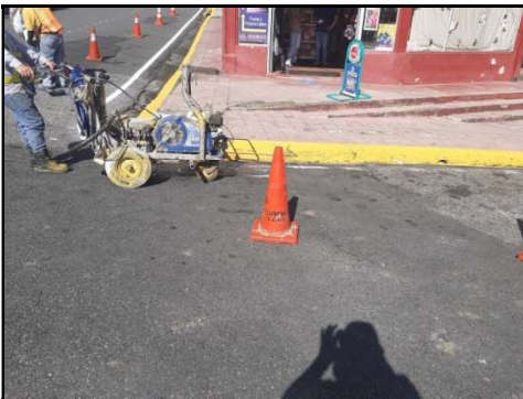
Figuras 39 y 40. Labores de demarcación de línea de borde.
