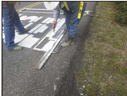
Figuras 41 y 42. Labores de demarcación de letreros.
