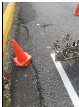
Figuras 39 y 40. Labores de demarcación de línea de borde.
