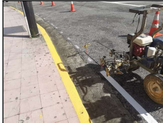
Figuras 8 y 9. Labores de demarcación de línea de borde.
