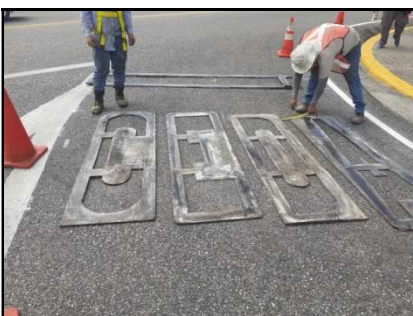
Figuras 41 y 42. Labores de demarcación de letreros.
