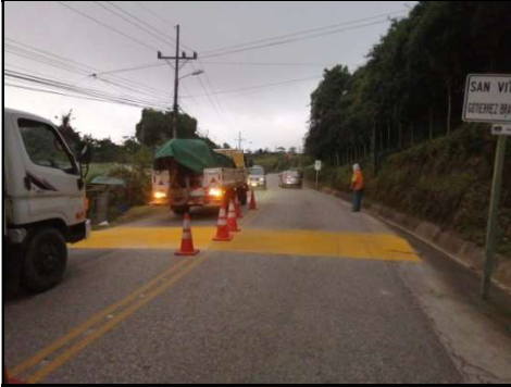
Figuras 18 y 19. Labores de demarcación de reductor de velocidad
