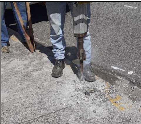
Figuras 26 y 27. Labores de elaboración de huecos.
