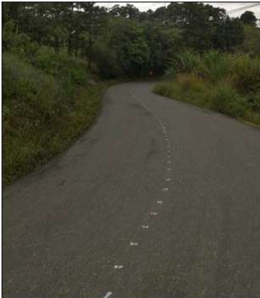
Figuras 4 y 5. Labores de punteo de línea de centro.
