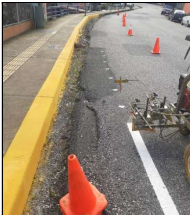
Figuras 8 y 9. Labores de demarcación de línea de borde.
