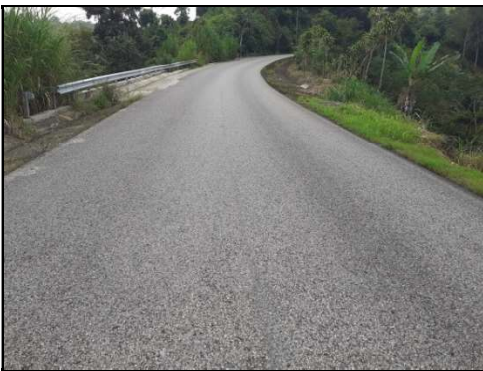
Figuras 32 y 33. Demarcación horizontal inexistentes antes de la ejecución del proyecto
