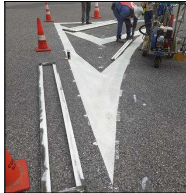
Figuras 10 y 11. Labores de demarcación de islas canalizadoras
