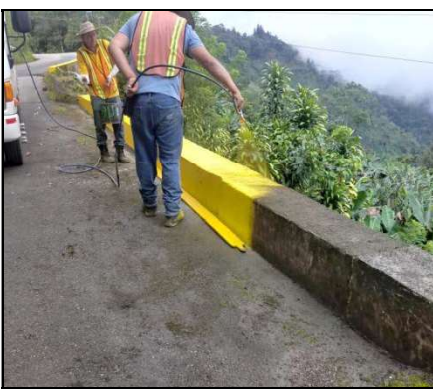
Figuras 22 y 23. Labores de demarcación de bordes de asfalto y cemento
