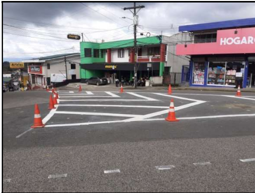
Figuras 10 y 11. Labores de demarcación de islas canalizadoras
