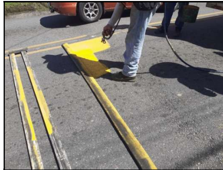
Figuras 18 y 19. Labores de demarcación de reductor de velocidad
