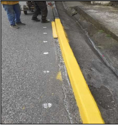
Figuras 20 y 21. Labores de demarcación de cordón amarillo
