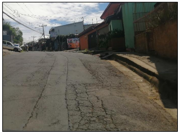
Figuras 2 y 3. Calle Molino, grietas longitudinales y piel de cocodrilo, San Josecito, San Rafael de Heredia. Fuente: Propia.
