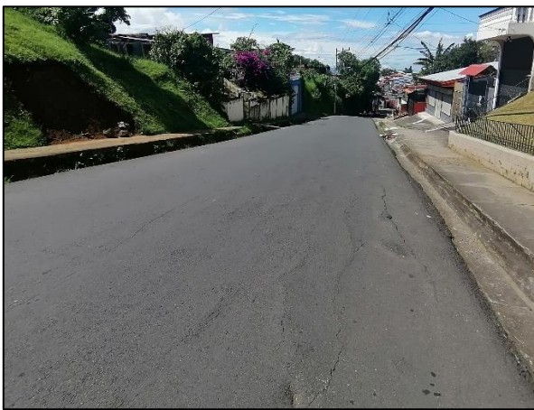
Figuras 2 y 3. Calle Molino, grietas longitudinales y piel de cocodrilo, San Josecito, San Rafael de Heredia. Fuente: Propia.
