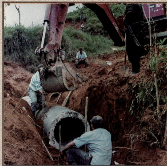
El proyecto M.O.P.T./GTZ procura la rehabilitación de 150 km de caminos priorizados en Pérez Zeledón con una inversión de ₡700 millones.
