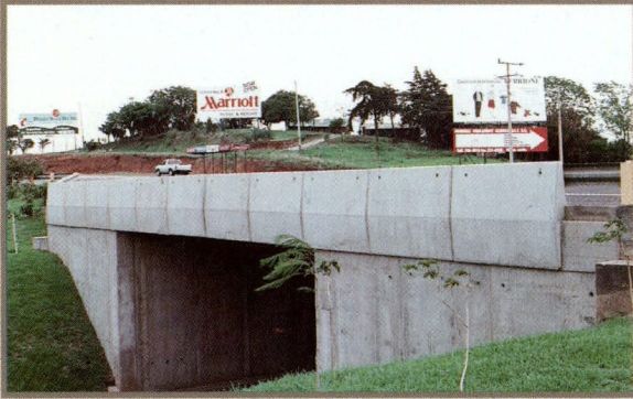
En la construcción de la nueva intersección Multiplaza, el MOPT utilizó en su mayor parte componentes prefabricados
