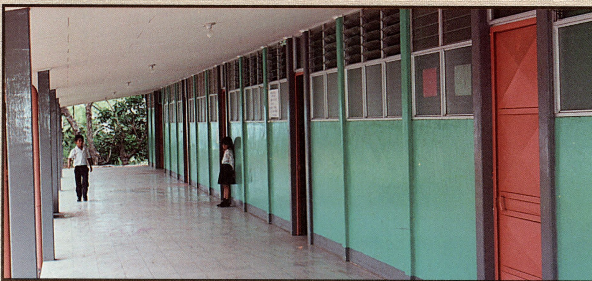
El M.O.P.T. promueve, mediante la Dirección de Edificaciones Nacionales, la construcción y mantenimiento de infraestructura educativa.
