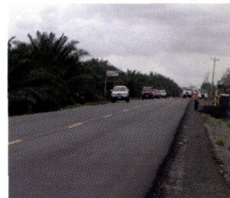
Rehabilitación de sección Parrita - Quepos de la Costanera Sur
