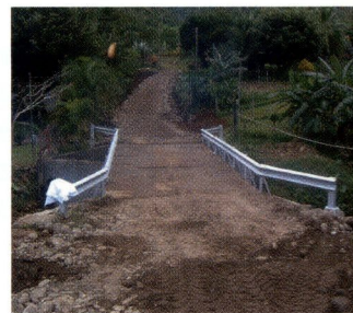
Una de las 7 estructuras construídas recientemente por Obras Públicas del MOPT en la región de San Ramón
