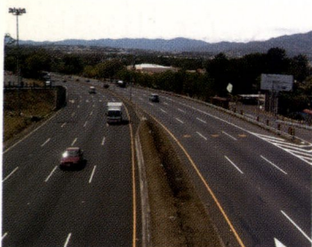
Mantenimiento de la autopista General Cañas
