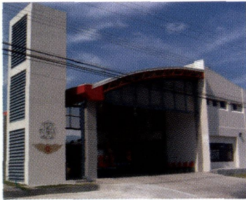
Con una inversión de ¢114 millones se construyó la Estación de Bomberos en el Aeropuerto Internacional Tobías Bolaños
