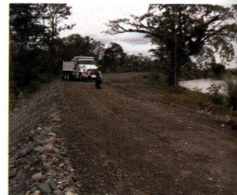
Dique de Matina, obra de protección para la comunidad ante las llenas del Río Reventazón
