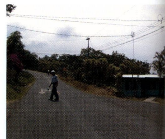
Así luce la Calle Chaparral - Concepción luego de la colocación de un sello asfáltico
