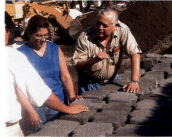
La Ing. María Lorena López, Viceministra de Obras Públicas inspeccionó el adoquinado de las calles urbanas de Hojancha, Nandayure, Nicoya, Santa Cruz, Liberia y La Cruz
