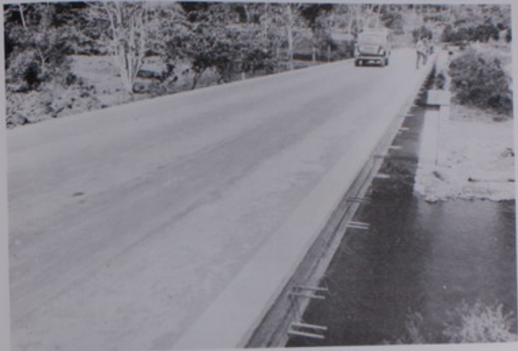
PUENTE SAN LORENZO.- El puente sobre el río San Lorenzo es una magnífica estructura que construye el MOPT, con el proyecto que une a San Ramón con San Isidro de Peñas Blancas.
