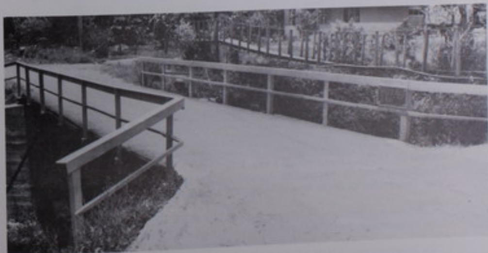
Este puente localizado en Dulce Nombre de Coronado, fue construido por el Departamento de Ayuda Comunal, con el aporte del Comité Los Angeles de esa localidad.
