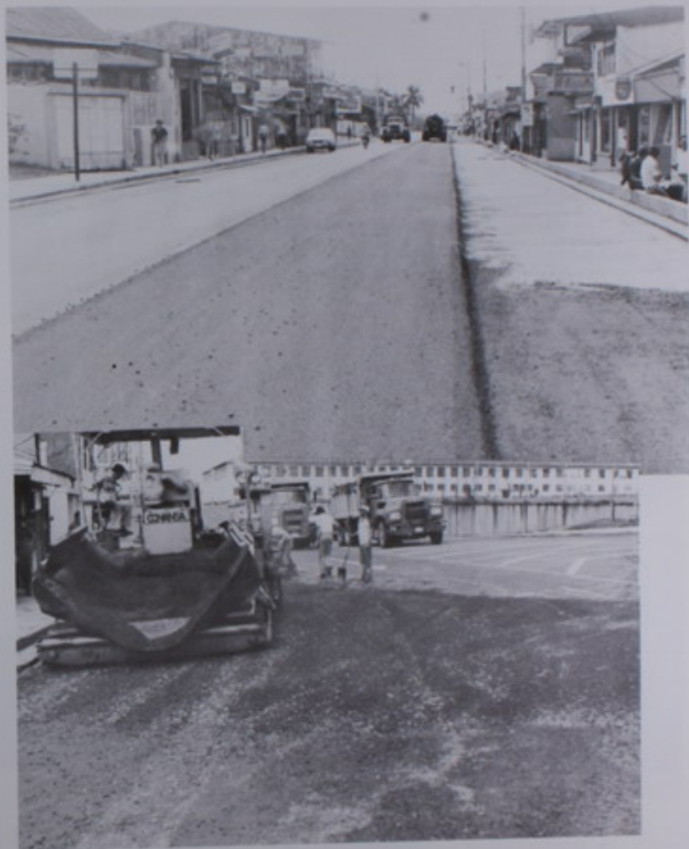
Una de las obras que realizó el MOPT para el mejoramiento de las carreteras en todo el país, lo fue la colocación de una carpeta asfáltica sobre la vía que une a San Francisco de Dos Ríos con la Plaza González Viquez.
