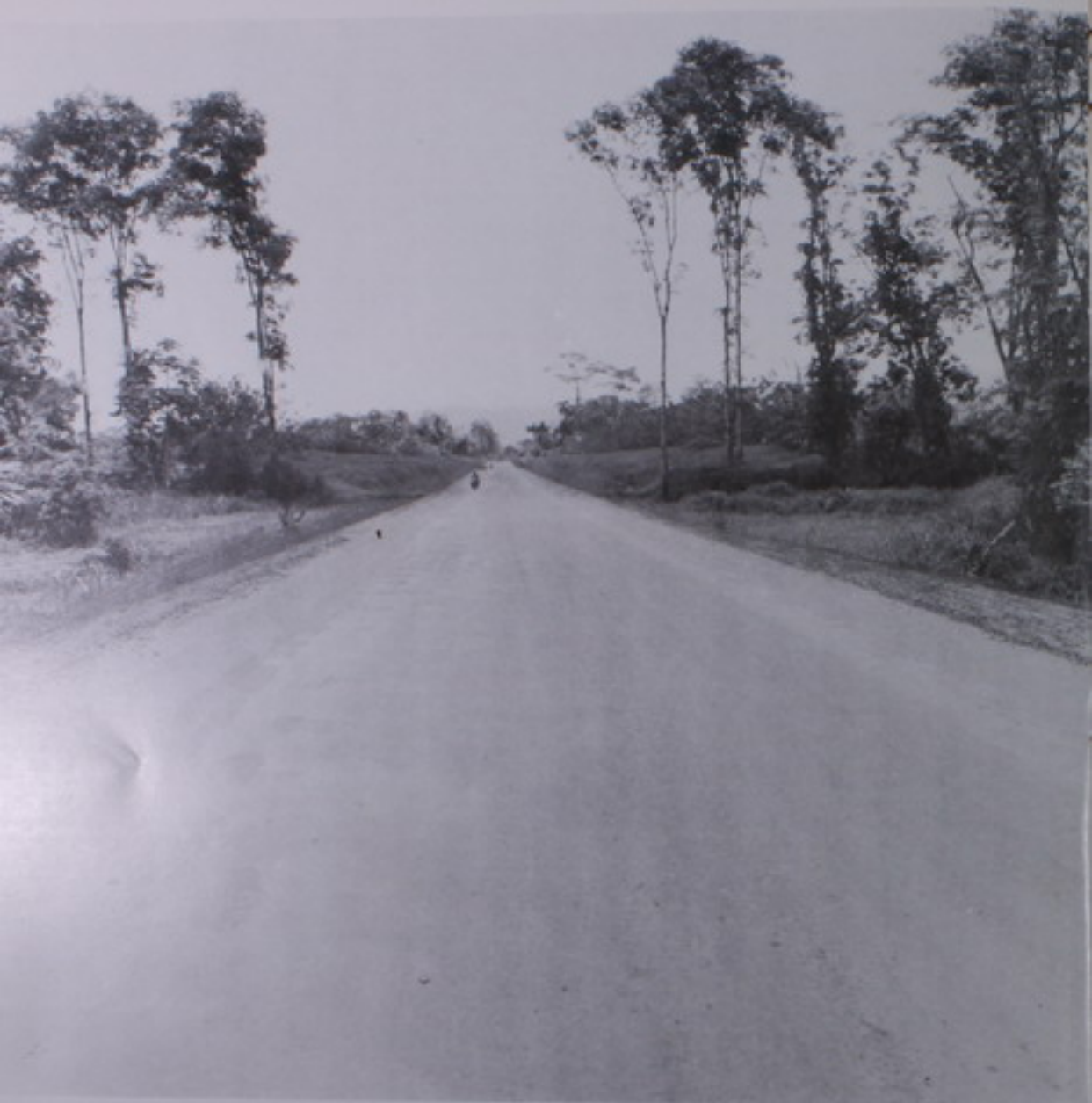
Panorámica de la carretera que construye el Ministerio de Obras Públicas y Transportes, entre las localidades de Siquirres y Guácimo. La obra contará con magníficas estructuras, como por ejemplo el Puente Parismina y se financia mediante un préstamo otorgado por el Banco Internacional de Reconstrucción y Fomento al Gobierno de Costa Rica.
