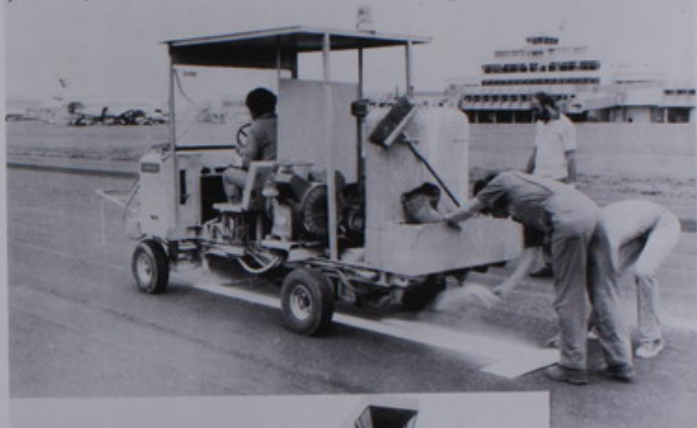
Funcionarios del MOPT realizan labores de señalamiento en la pista de aterrizaje del Aeropuerto Internacional Juan Santamaría.
