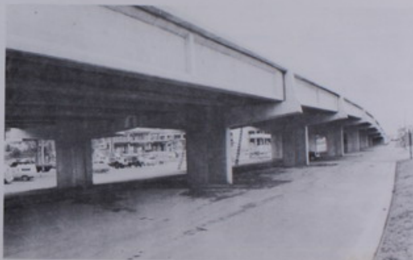
Puente elevado frente al Hospital México
