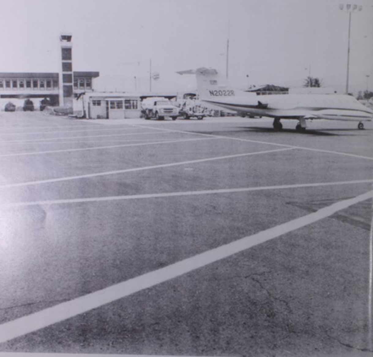
Vista parcial de las modernas instalaciones del Aeropuerto Internacional Juan Santamaría. Al fondo aparece la Estación de Bomberos y se observa parte de la pista que asfaltó el MOPT.
