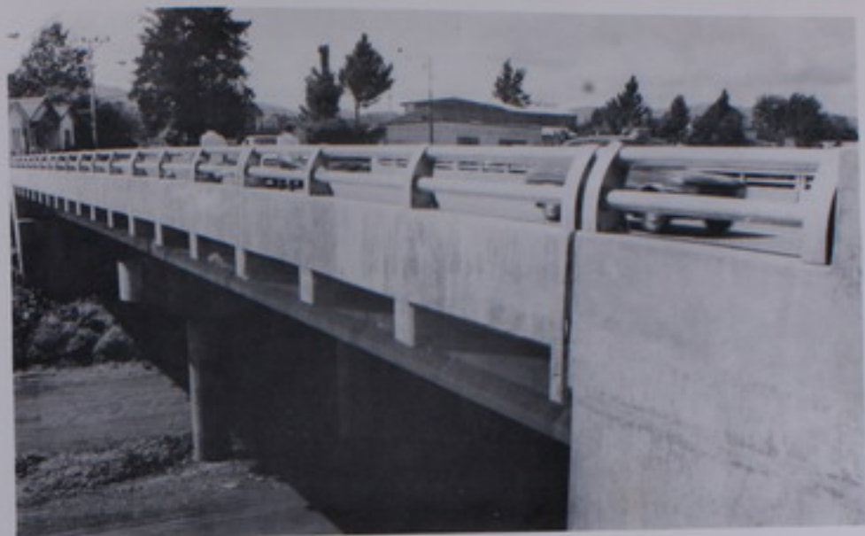
El Puente Velez es una de las magníficas estructuras que construyó el Ministerio de Obras Públicas y Transportes en la carretera de circunvalación norte. Se ubica en Zapote, cerca de la Casa Presidencial y su construcción proporciona mayor agilidad al sistema vial.
