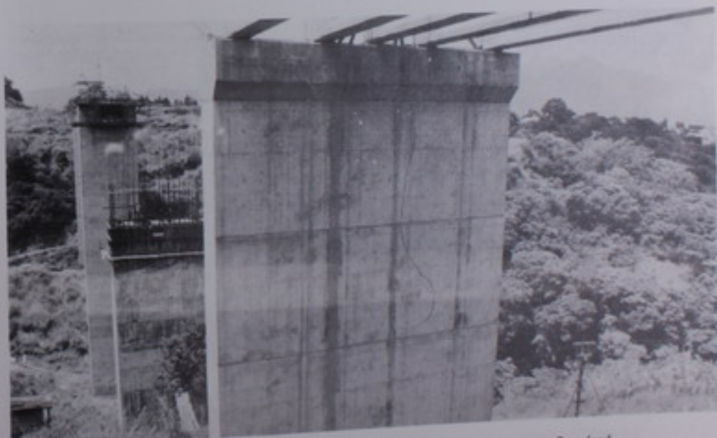
Una de las magníficas estructuras que se construyen en la carretera San José – Siquirres – Puerto Viejo, es el puente sobre el río Virilla que tiene una longitud de 185 metros.
