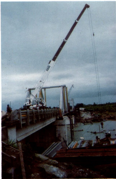
Puente sobre el Río Cañaza. Puente San Isidro en la provincia de Heredia. Puente sobre el Río La Estrella. Muelle sobre el Río Sarapiquí en Puerto Viejo.
