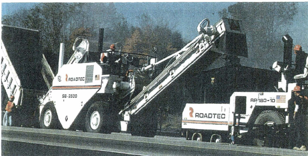
FIGURA 10.17 VEHÍCULO DE TRANSFERENCIA DE MATERIAL "SHUTTLE BUGGY"
