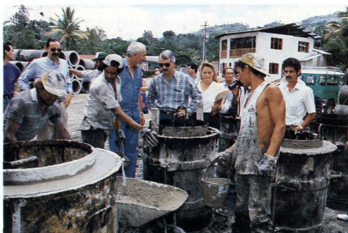
Las comunidades organizadas trabajaron intensamente para construir 3.200 metros lineales de tubo empleado en drenajes.
