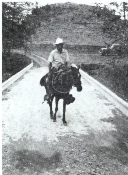
Con mano de obra aportada por las comunidades y materiales que suple el MOPT se construyeron puentes para accesar zonas productoras.
