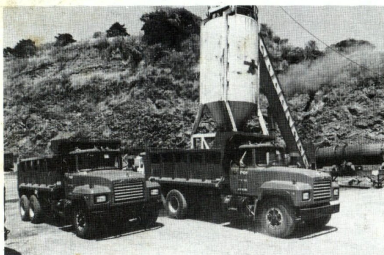
Con nuevo equipo el MOPT inició la integración de brigadas básicas para el mantenimiento vial
