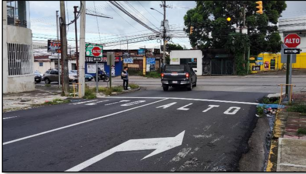
Figura. 5 Condiciones del Señalamiento vial de la calzada, Calle 73D, sector El Alto, Guadalupe, Goicoechea. Vista Sur-Norte.
