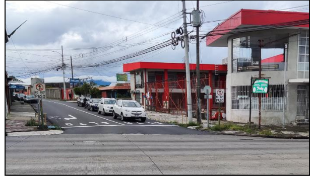
Figura. 6 Condiciones del Señalamiento vial de la calzada, Calle 73D, sector El Alto, Guadalupe, Goicoechea. Vista Norte-Sur.
