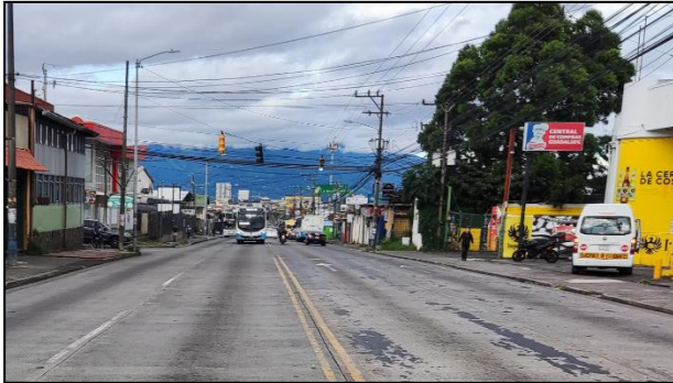
Figura. 3 Condiciones del Señalamiento vial de la calzada, Ruta Nacional N°218, sector El Alto, Guadalupe, Goicoechea. Vista Este –Oeste.
