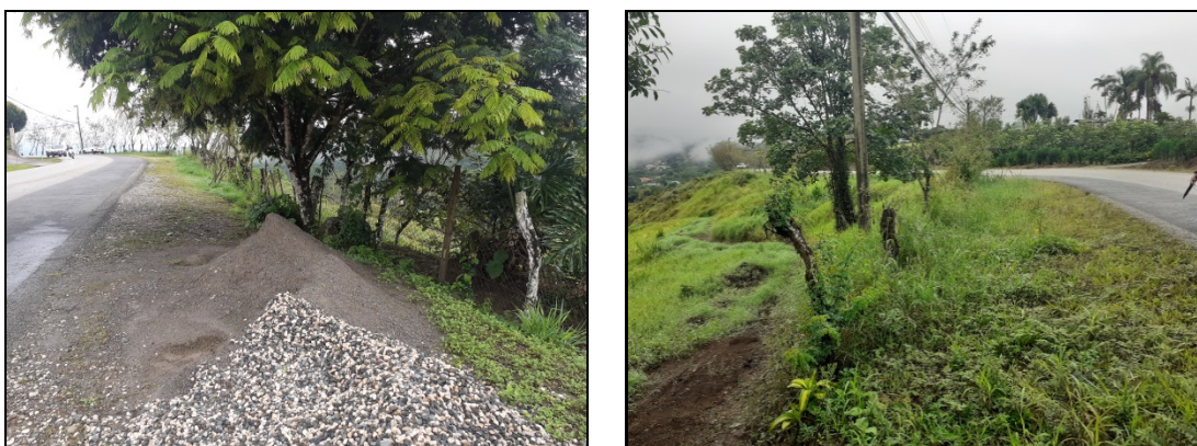
Figuras 40 y 41. Precipicio en San Vito - Gutiérrez Braun en la margen de la calzada del sitio 08.
