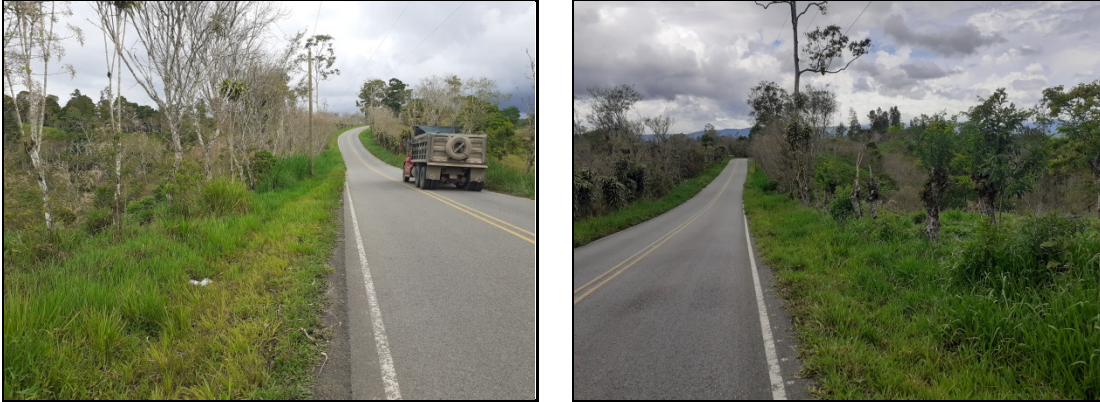
Figuras 152 y 153. Precipicio en Gutiérrez Braun - San Vito en la margen de la calzada del sitio 36.
