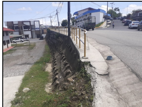
Figuras 10 y 11. Talud paralelo no traspasable en la margen de la calzada del sitio 01.
