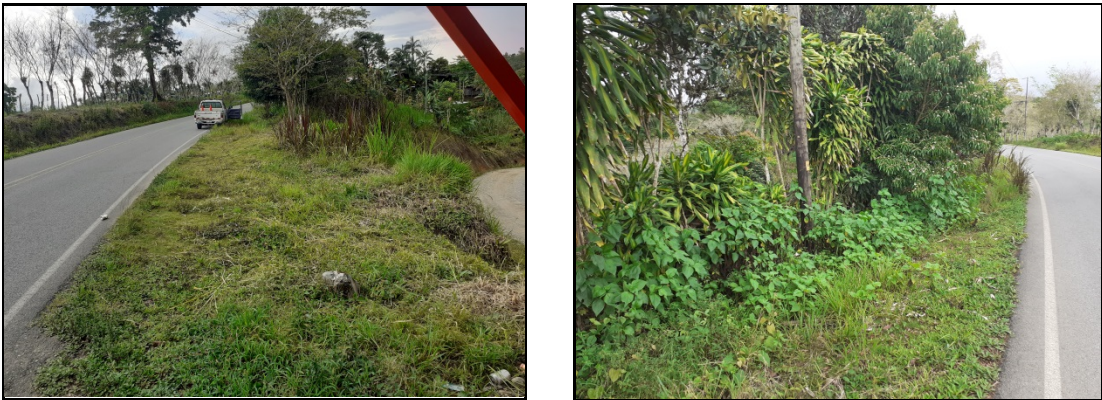
Figuras 172 y 173. Precipicio en San Vito - Gutiérrez Braun en la margen de la calzada del sitio 41.
