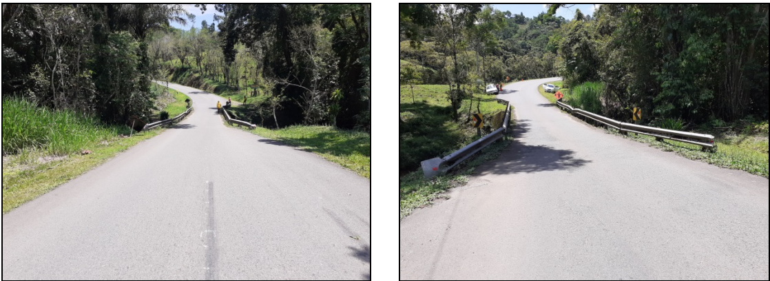
Figuras 136 y 137. Plataforma de un puente ambos sentidos en la margen de la calzada del sitio 32.
