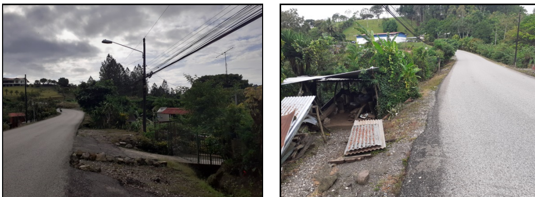
Figuras 56 y 57. Precipicio en San Vito - Gutiérrez Braun en la margen de la calzada del sitio 12.
