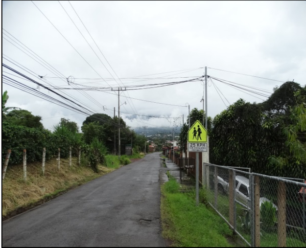
Figura N° 5 Señalamiento vial existente y no hay aceras.
