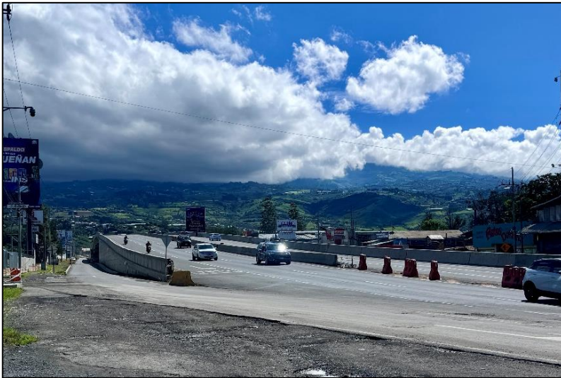
Ilustración 17 Construcción carriles de transición en el inicio del proyecto.
