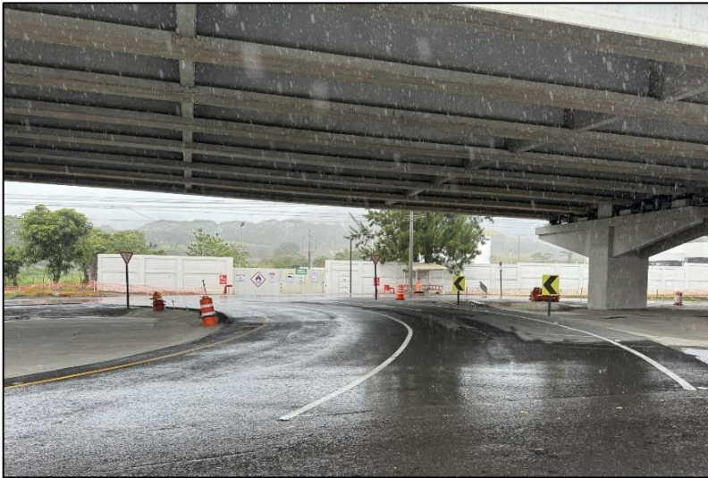
Ilustración 4 Rotonda bajo paso elevado sector aledaño a la Avenida 23.
