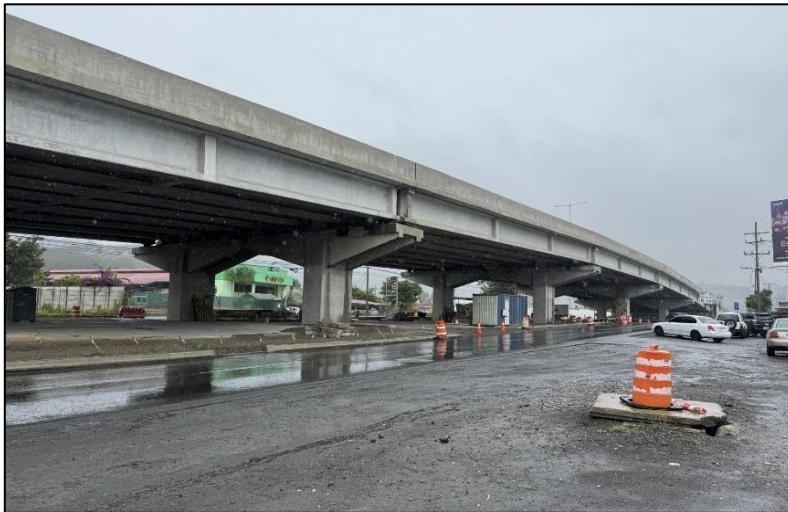
Ilustración 11 Vista general paso elevado en sector aledaño a la Avenida 23.
