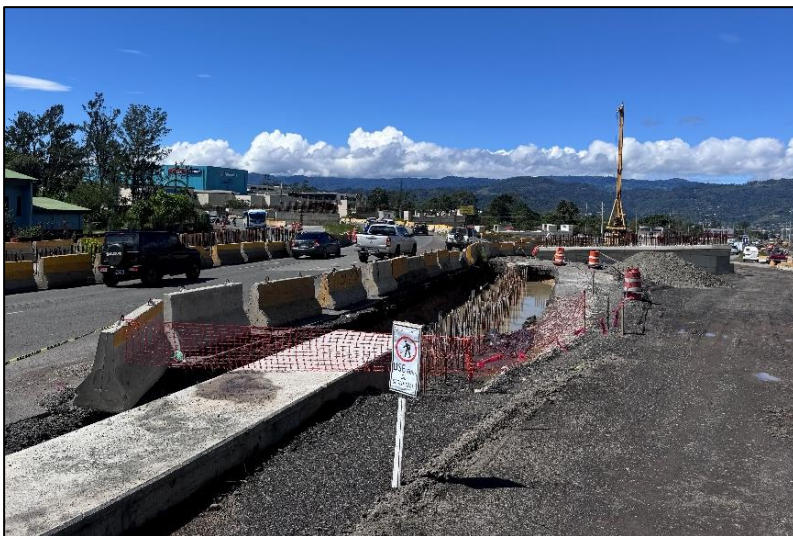
Ilustración 18 Avance general de obras en la zona de La Lima.
