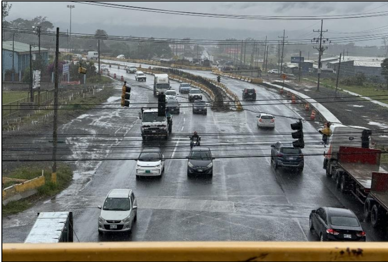
Ilustración 21 Se ilustra el paso elevado sobre el intercambio con la Ruta Nacional No. 10
