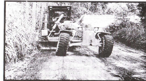
Fig 2. Labores de mantenimiento mecánico.
