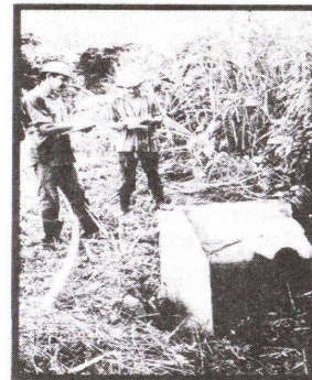
Fig 8. Limpieza de alcantarillas
