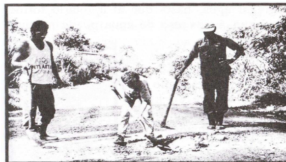
Fig 12. Trabajadores escarban un bache.
