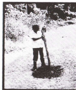
Fig 13. Labores de compactación para finalizar la reparación.
