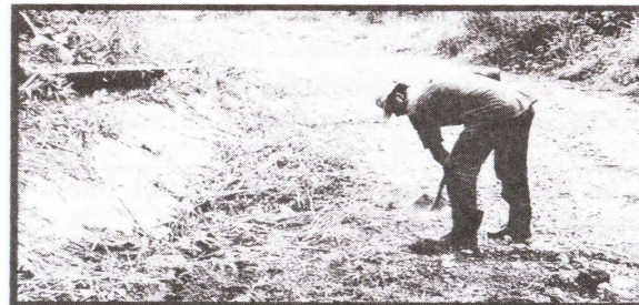
Fig 11. Mantenimiento de un canal transversal.
