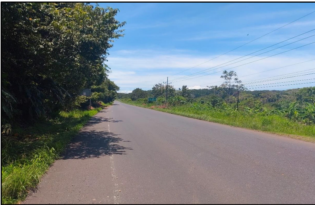
Imagen N° 2. Tramo de Ruta Nacional N° 34 sin demarcación.
