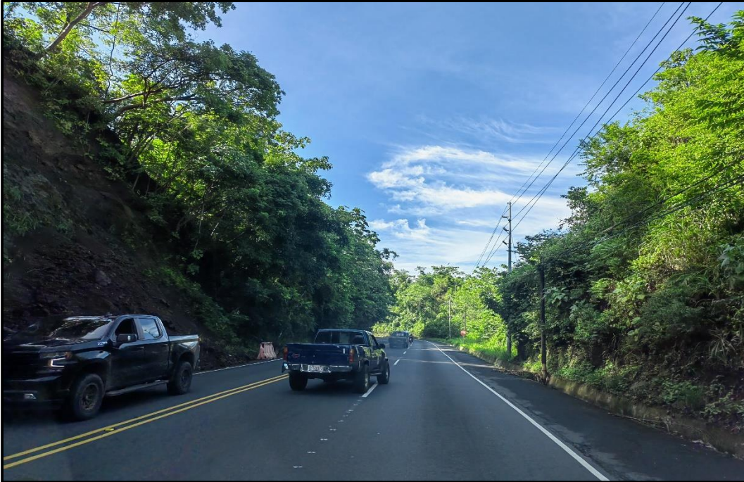
Imagen N° 7. Línea de borde continua blanca demarcada.
