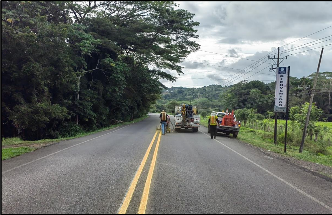
Imagen N° 4. Trabajos de demarcación de línea de centro con máquina manual.
