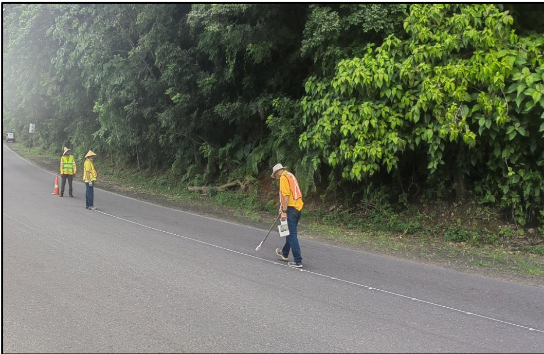
Imagen N° 3. Trabajos de punteo en carriles de ascenso.
