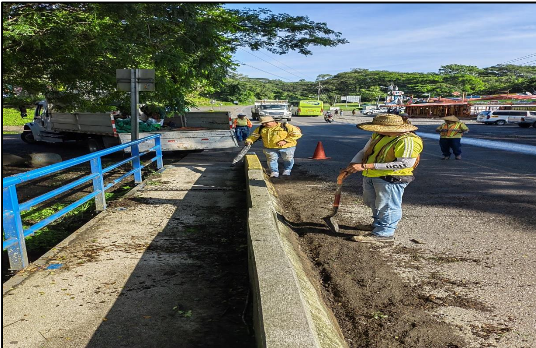
Imagen N° 10. Limpieza para demarcación de línea de borde.
