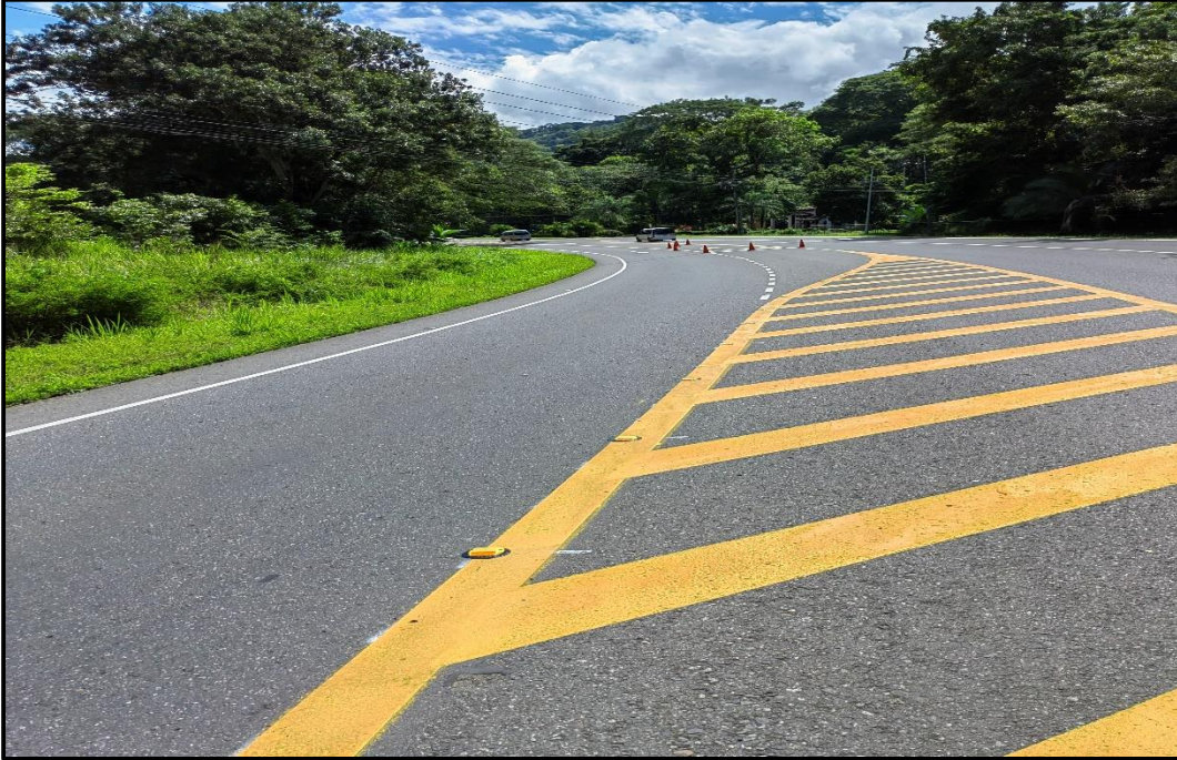
Imagen N° 8. Demarcación islas canalizadores, flechas direccionales y letreros.
