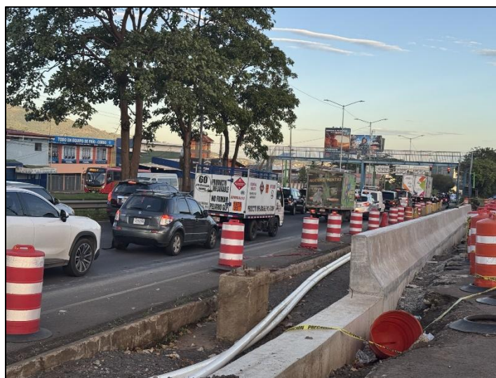
Fotografía 11 Vista general de este a oeste. Puentes peatonales a demoler y avance en ruta marginal.
