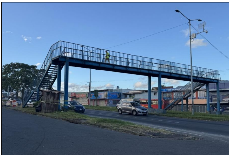
Fotografía 6 Puente peatonal existente a demoler.
