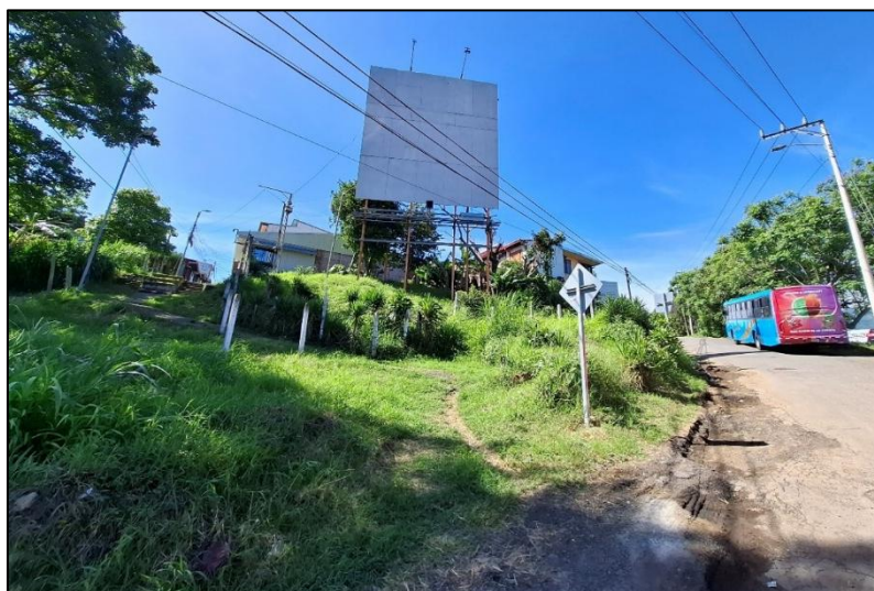
Fotografía 21 Acceso peatonal tradicional que da salida al proyecto desde la calle Av. 20. Muestra de los accesos que deben ser garantizados y aclarados en el diseño del proyecto. Hatillo 8, junio 2025.
