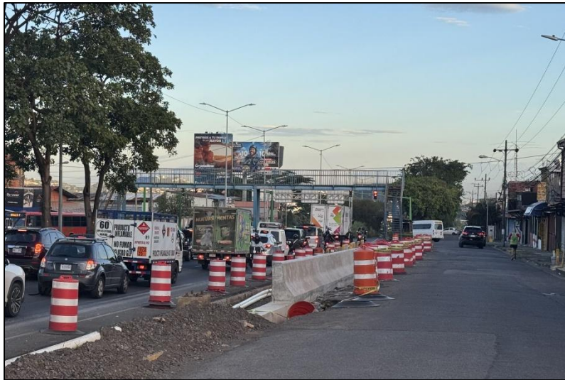
Fotografía 2 Vista general del proyecto, sentido este - oeste.
