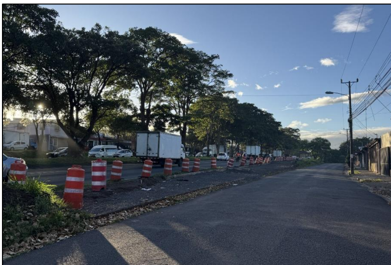
Fotografía 14 Visto del sector sur, punto donde termina el paso elevado y se debe construir tramo de marginal.
