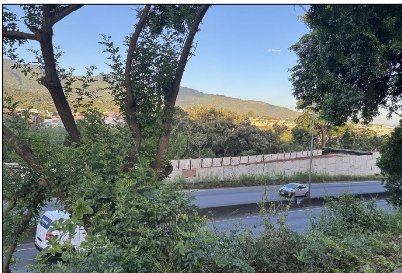
Fotografía 12 Visto general del sector sur, muros para conformar niveles del punto donde termina el paso elevado.
