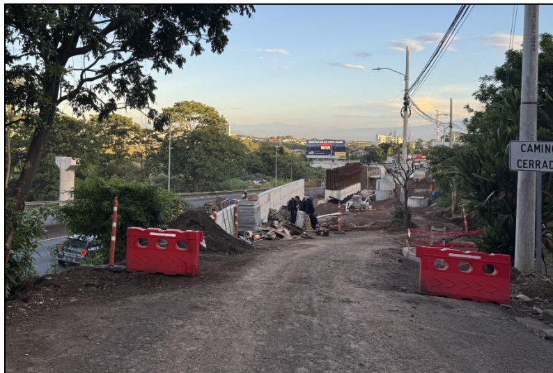
Fotografía 7 Paso a desnivel curvo, avance del mismo visto de este a oeste.
