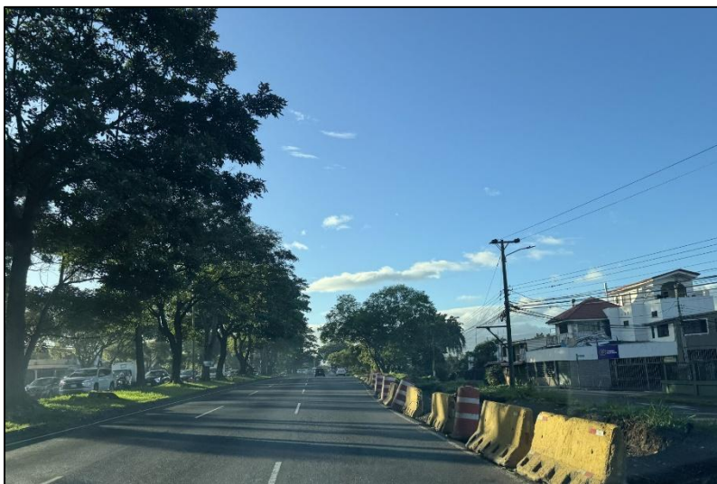
Fotografía 9 Avance sector sur, visto de oeste a este.
