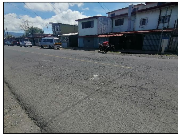
Figuras 2 y 3. Daños y grietas piel de cocodrilo en secciones de calzada Avenidas 69 y 71 respectivamente, Moravia, San José. Fuente: Propia.
