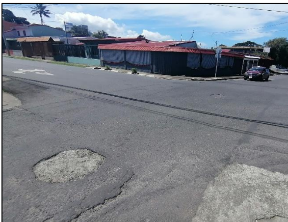
Figuras 2 y 3. Daños y grietas piel de cocodrilo en secciones de calzada Avenidas 69 y 71 respectivamente, Moravia, San José. Fuente: Propia.
