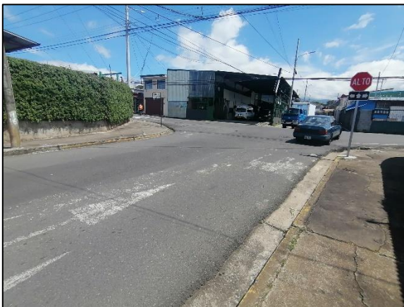
Figuras 8 y 9. Secciones de la zona en estudio con demarcación horizontal desgastada, Moravia, San José. Fuente: Propia.
