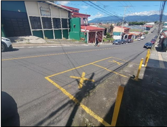
Figuras 6 y 7. Demarcación horizontal observada y cordón amarillo desgastado, tramo Calle 67, Moravia, San José. Fuente: Propia.
