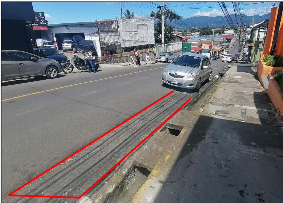
Figura 5. Sobrancho sin nivel con la calzada Calle 67, Moravia, San José. Fuente: Propia.
