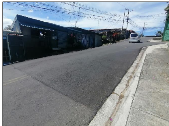
Figuras 8 y 9. Secciones de la zona en estudio con demarcación horizontal desgastada, Moravia, San José. Fuente: Propia.
