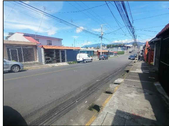
Figuras 6 y 7. Demarcación horizontal observada y cordón amarillo desgastado, tramo Calle 67, Moravia, San José. Fuente: Propia.
