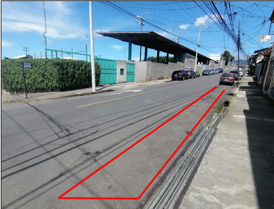
Figura 4. Sobrancho sin nivel con la calzada Calle 67 frente al Estadio Luis Ángel "Pipilo" Umaña, Moravia, San José. Fuente: Propia.
